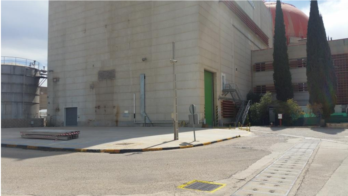
Estado actual Exteriores del Edificio de Administración y Explanada Norte EAD.
