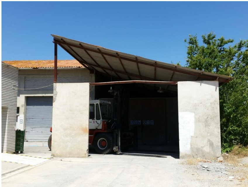
Fotografías 26. Estado actual zona aparcamiento medios mantención junto edificio desclasificables
