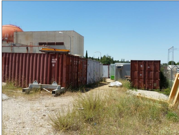
Fotografía 40. Ejemplos de contenedores ISO situados en la instalación
