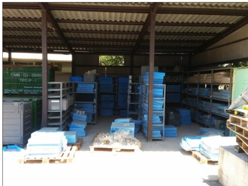
Fotografías 24 y 25. Estado actual cubierta anexa al edificio Box-Counter y cajas con testigos y sondeos a retirar
