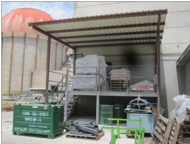
Fotografías 59 y 60. Estado actual zona acondicionamiento contenedores
