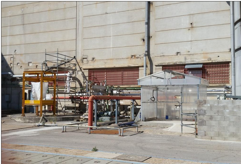
Fotografías 16 y 17. Estado actual equipamiento cara Este edificio EAD
