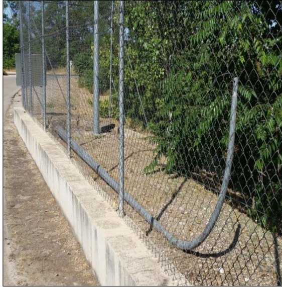
Fotografías 28 y 29. Báculos para iluminación inservibles
