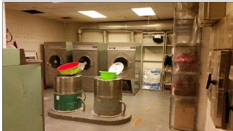
Fotografías 55 y 56. Estado actual lavandería zona controlada
