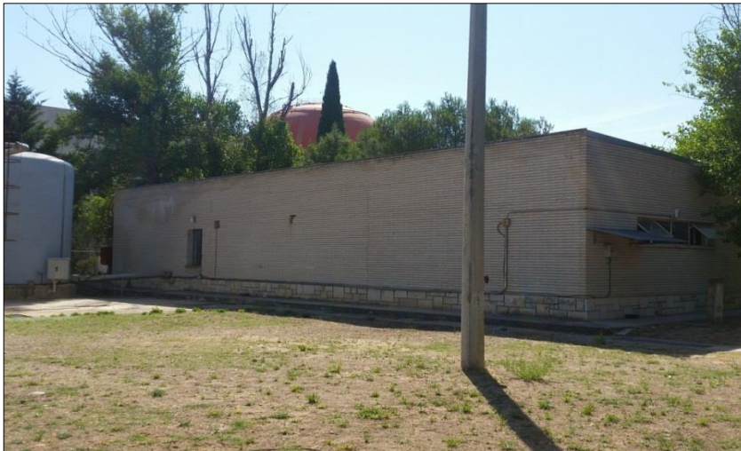
Fotografía 37. Vista exterior Edificio potabilizadora
