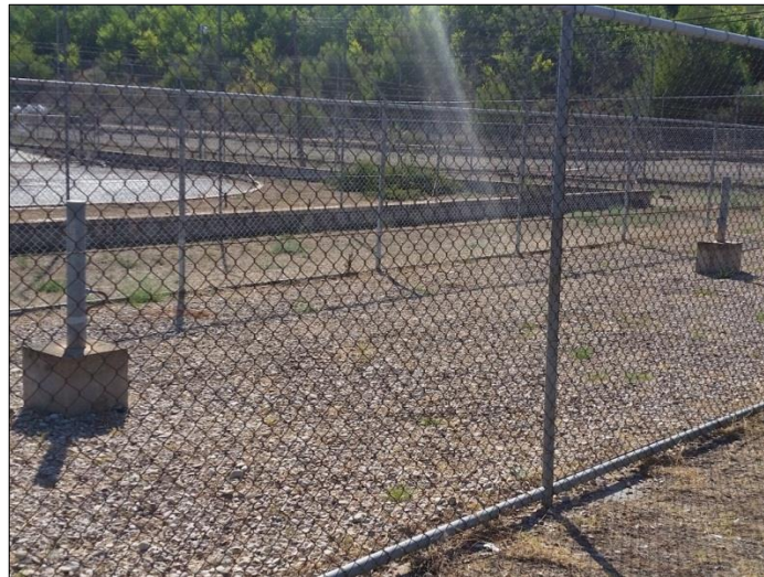
Fotografía 30. Ejemplo postes para barrera microondas (ubicados entre vallados)
