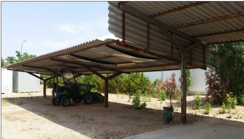
Fotografías 22 y 23. Estado actual cubierta aparcamiento
