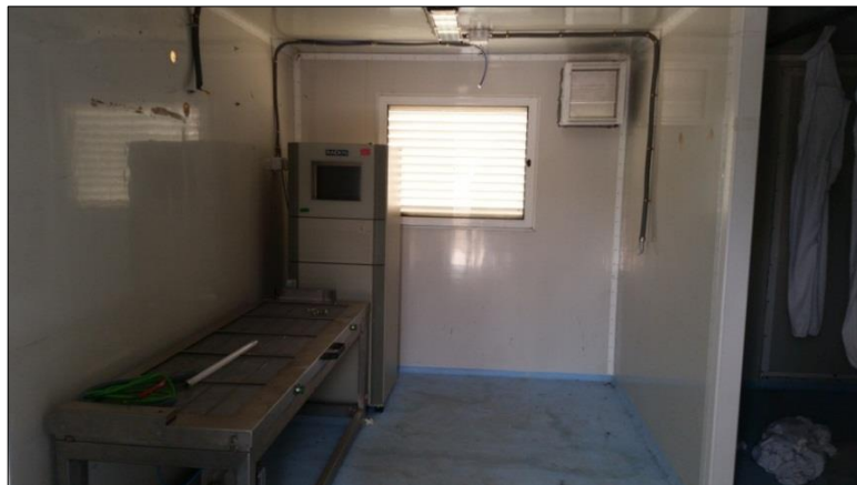
Fotografías 3 y 4. Estado actual lavandería modular. Vistas interiores
