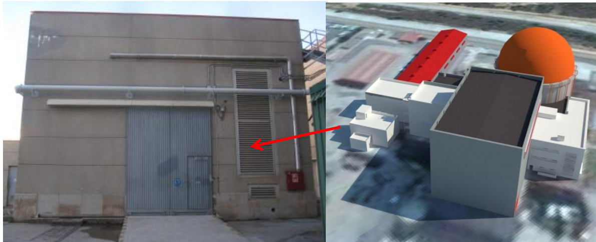
Figura 2. Vista General Edificio Diésel
