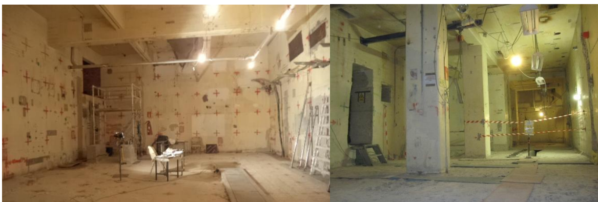
Figura 7. Forjado interior y disposición de pilares y muros (zona P22 y “L”)
