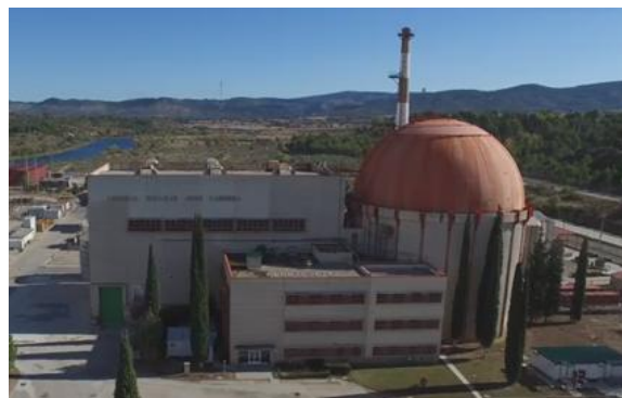
Figura 12. Vista General Edificio Oficinas
