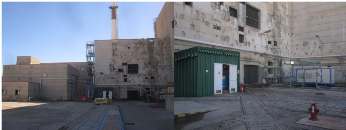
Figura 6.- Vista general exterior del Edificio Eléctrico
