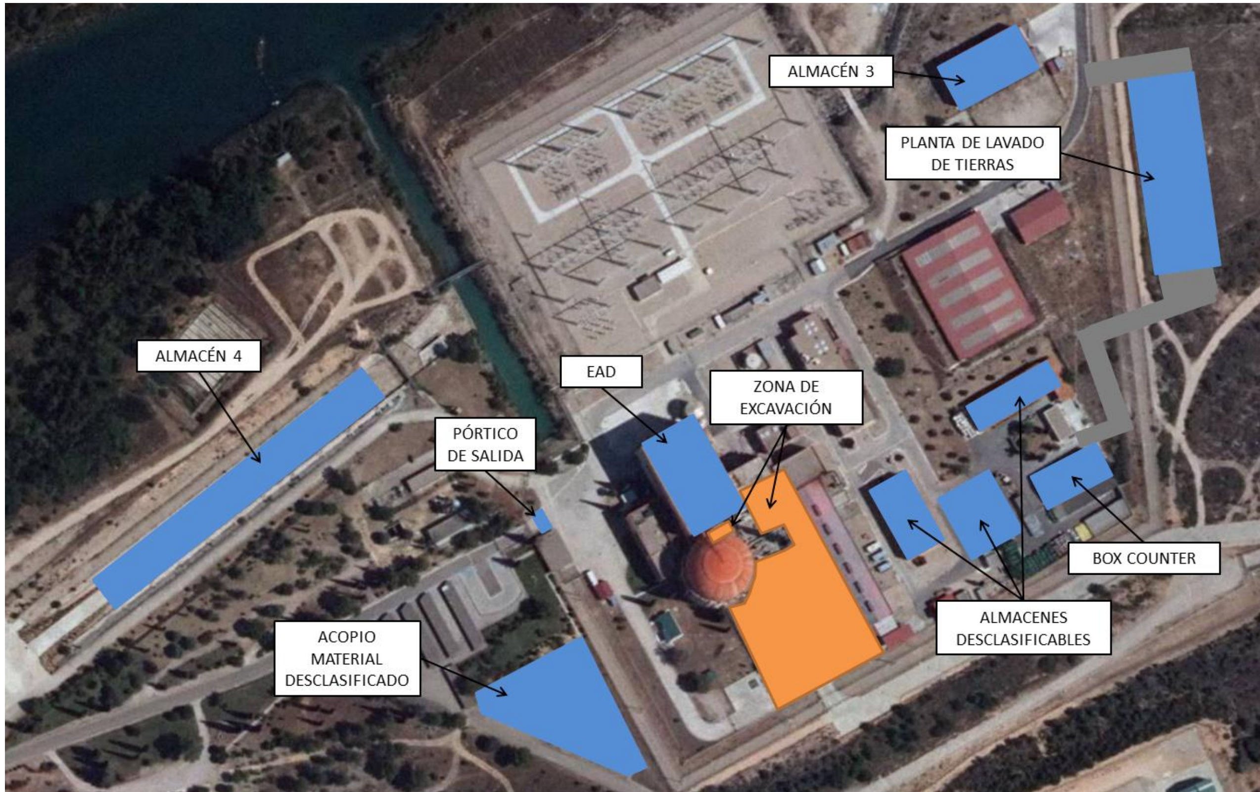
Figura A. 1 - Vista general del emplazamiento
