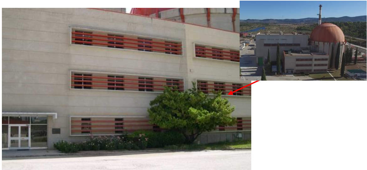
Figura 7. Edificio de oficinas
