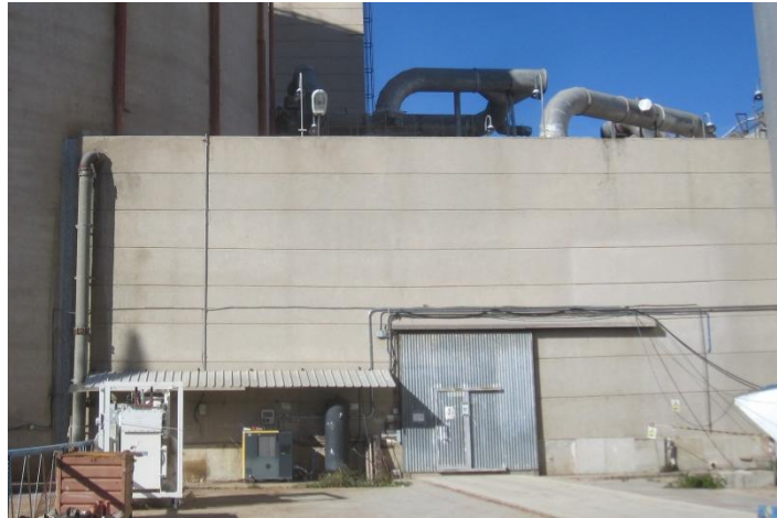
Figura 10. Portón sur ampliación del edificio auxiliar
