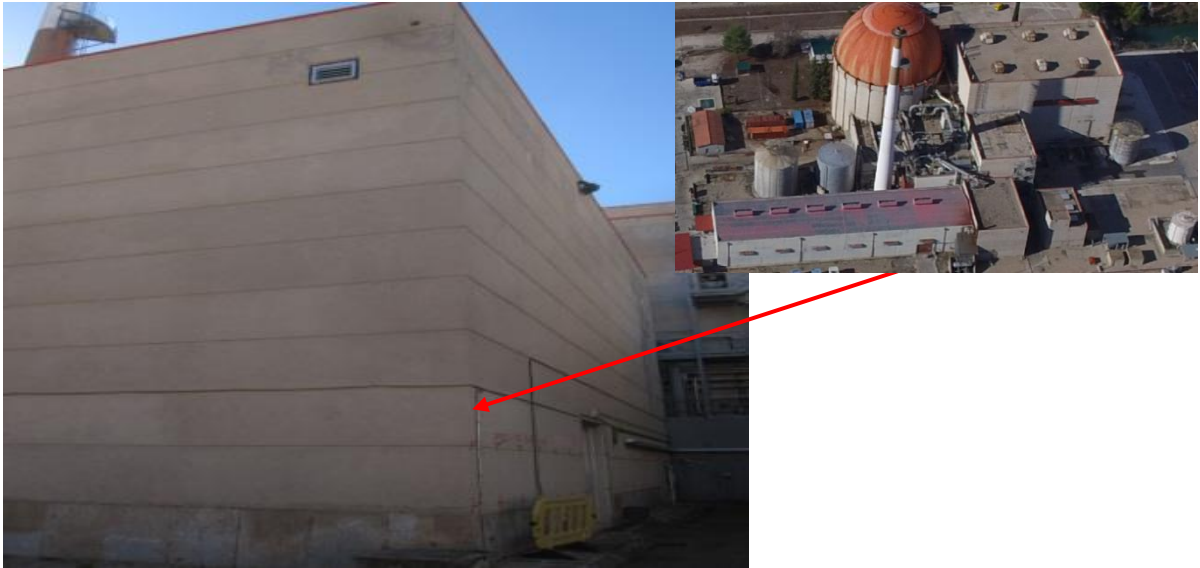
Figura 4. Edificio del evaporador
