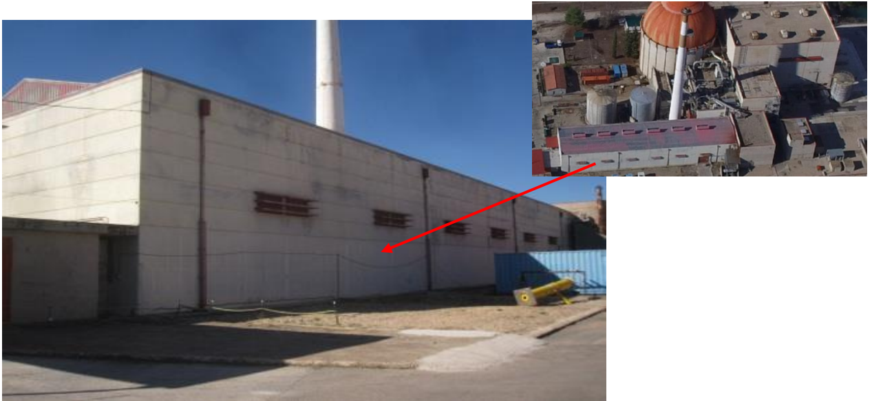
Figura 5. Almacén 1 de residuos
