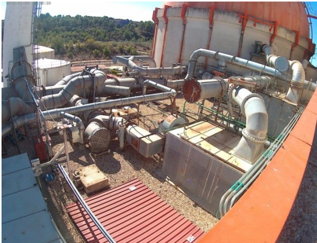
Figura 2. Ventilación Edif Auxiliar. Situación actual en terraza
