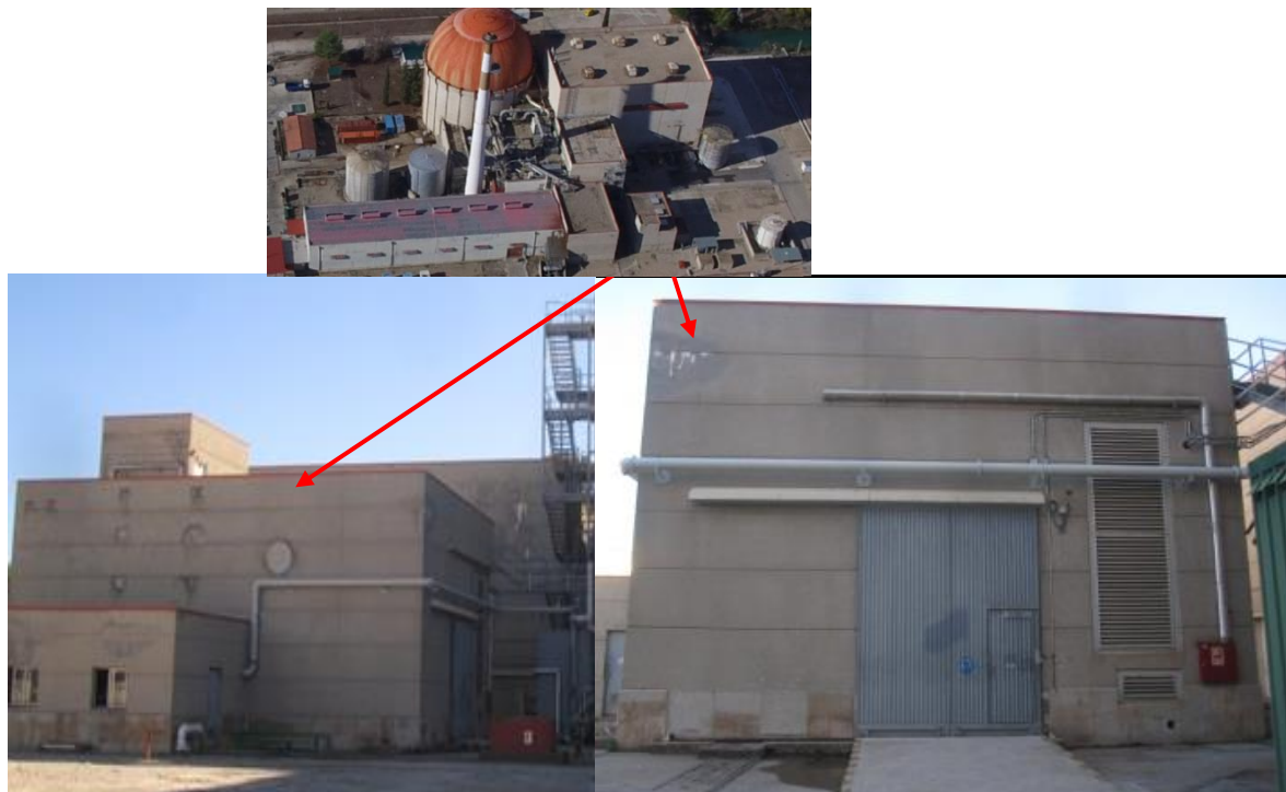
Figura 3. Edificio del generador diésel
