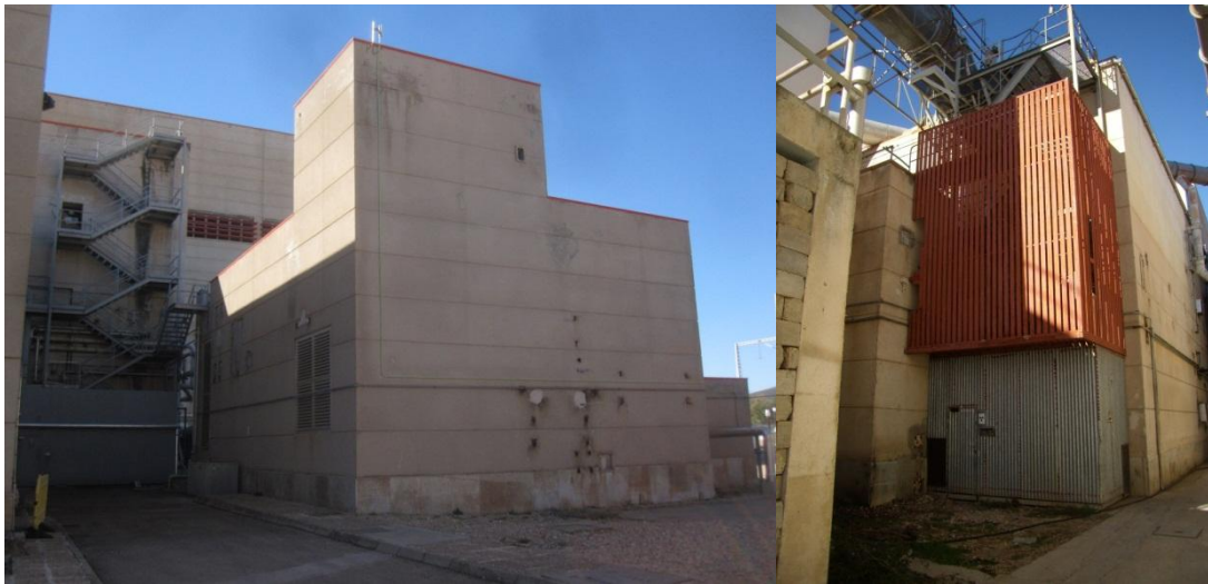
Figura 10. Escaleras exteriores del Edificio Eléctrico y escaleras de subida a terraza del edificio auxiliar
