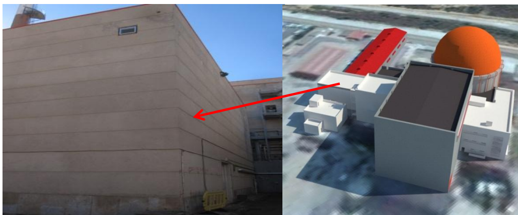
Figura 3. Vista general del Edificio del Evaporador
