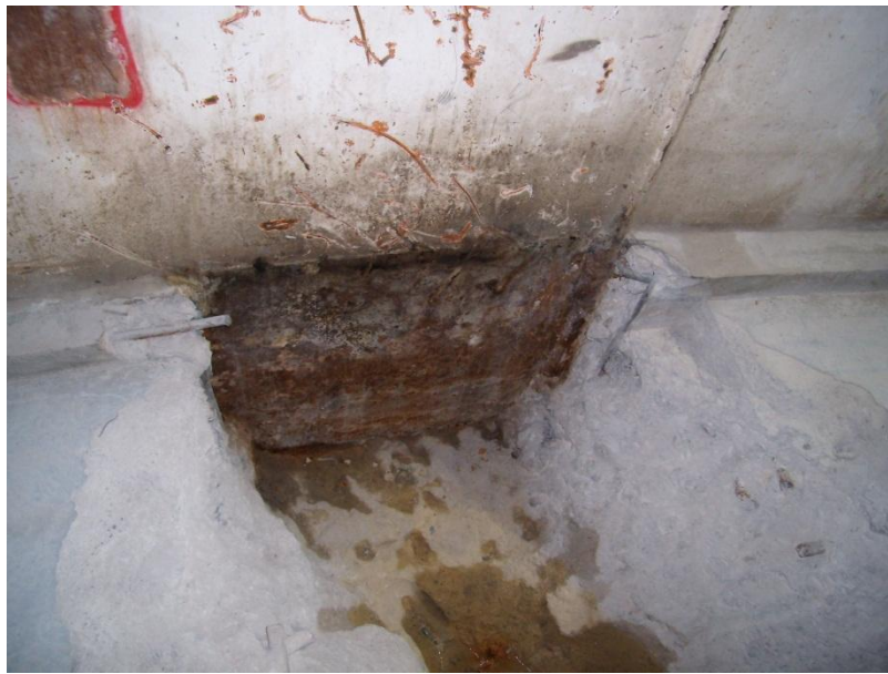
Figura 13. Limpieza del liner bajo cota +594.360
