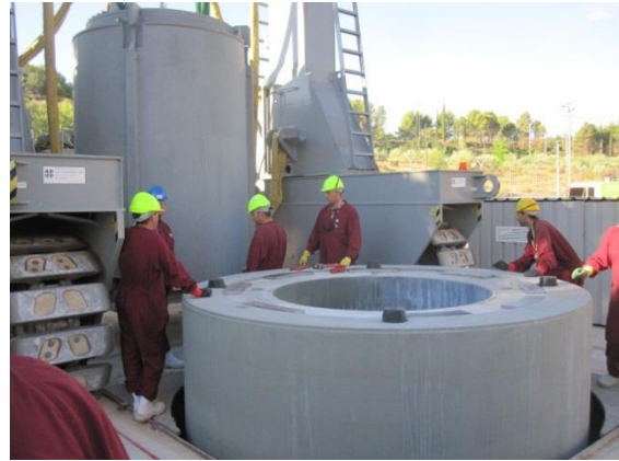
FIG. 10: COLOCACION DEL HI SAFE EN EL FOSO DE TRANSFERENCIA
