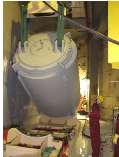
Fig.5: EQUIPO DOLLY CON EL HI-TRAC
