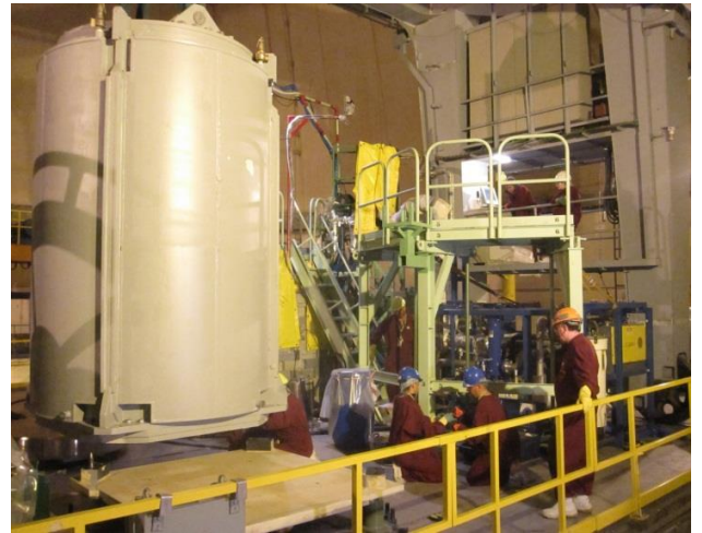
Fig.6: DRENAJE, SECADO Y LLENADO DE HELIO, DE LA CÁPSULA GWC
