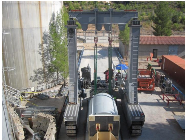
Fig. 8: VOLTEO DEL HI TRAC CON EL CRAWLER
