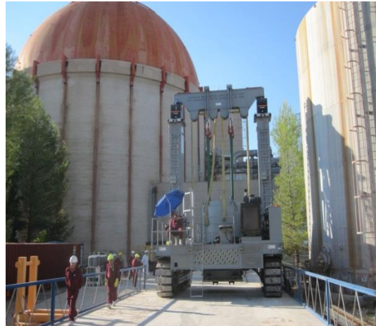
Fig. 9: TRASLADO CON EL CRAWLER DEL HI-TRAC, AL FOSO DE TRANSFERENCIA DEL ATI
