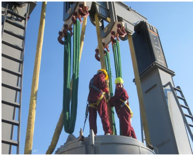
Fig.12: TRASPASO DE LA CÁPSULA GWC DEL HI-TRAC AL HI-SAFE Y COLOCACIÓN DE LA TAPA.
