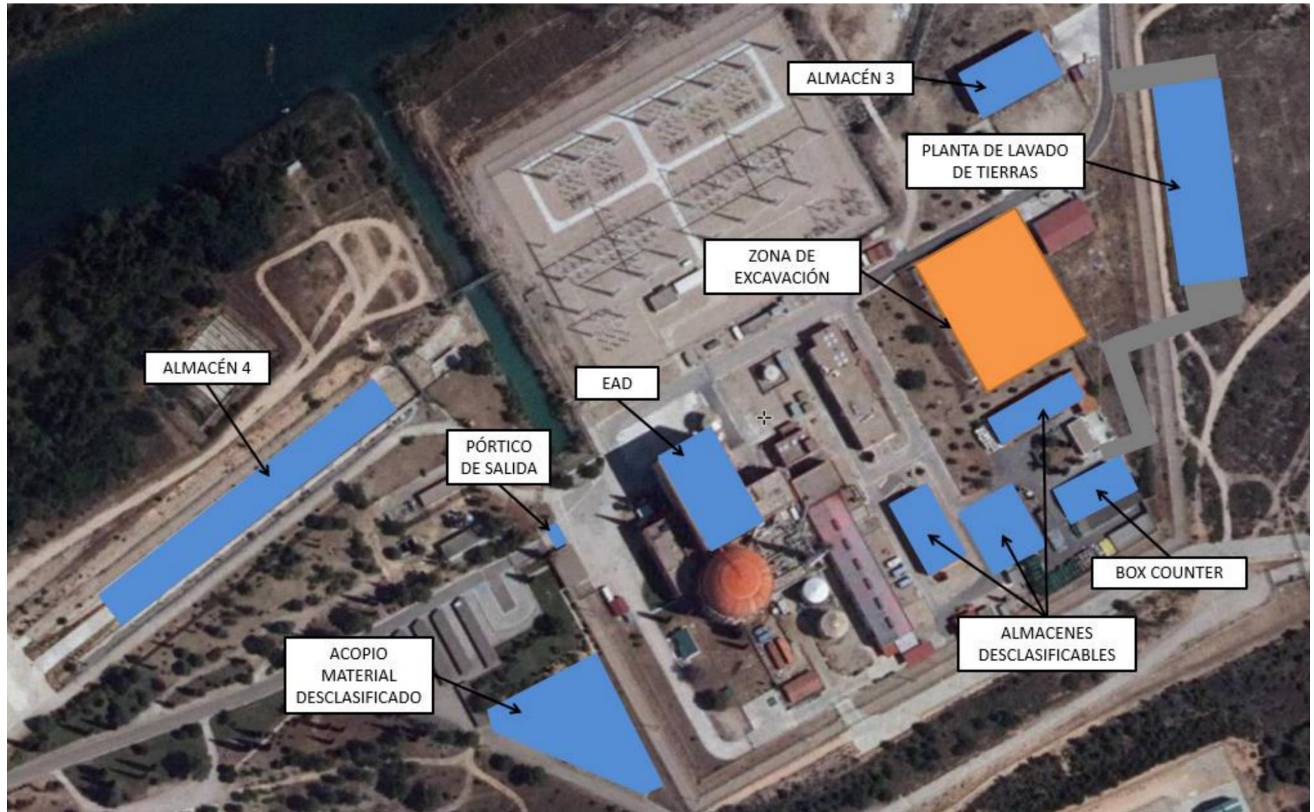
1-Vista general del emplazamiento
