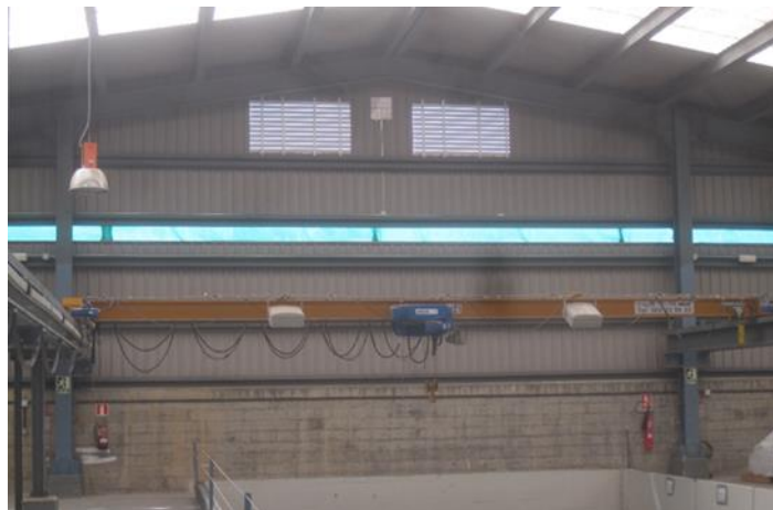
Figura 11. Detalle muro perimetral (sur)
