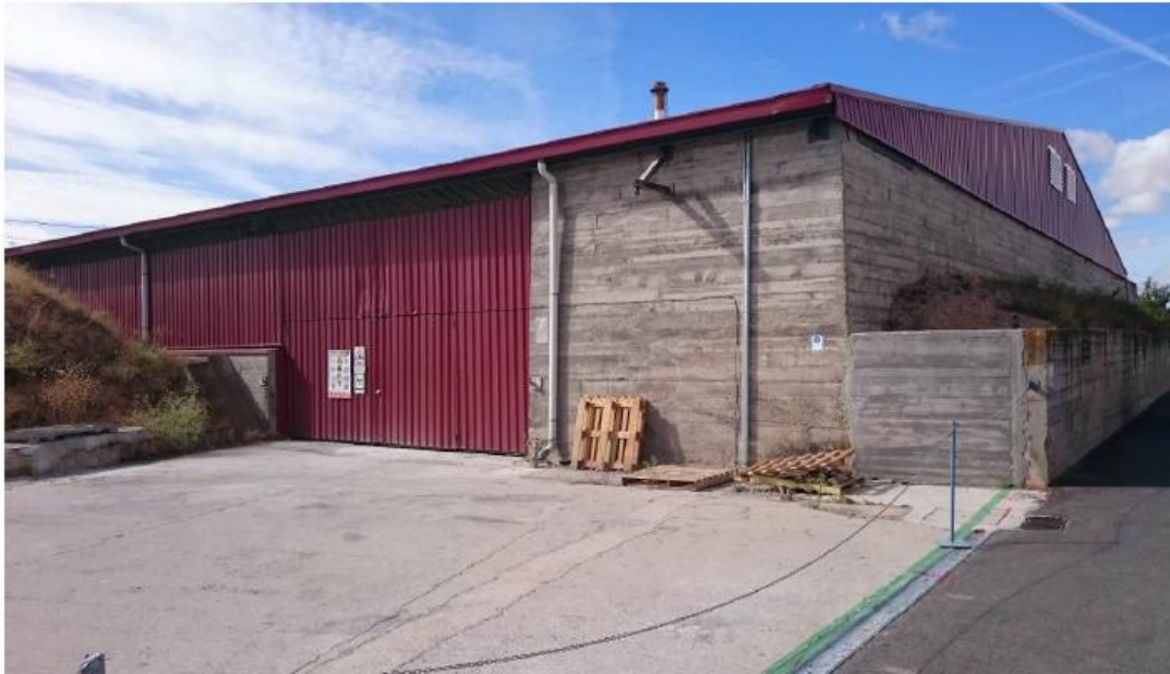
Figura 8. Acceso principal y muro norte
