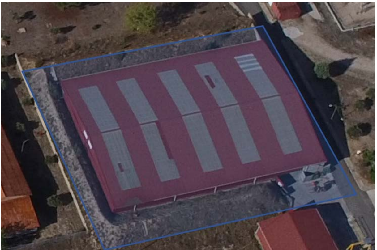
Figura 1 – Zona de intervención
