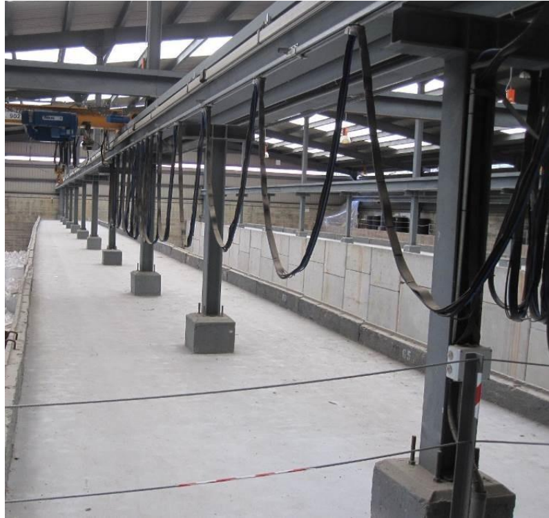
Figura 9. Detalle pilares y vigas carrileras
