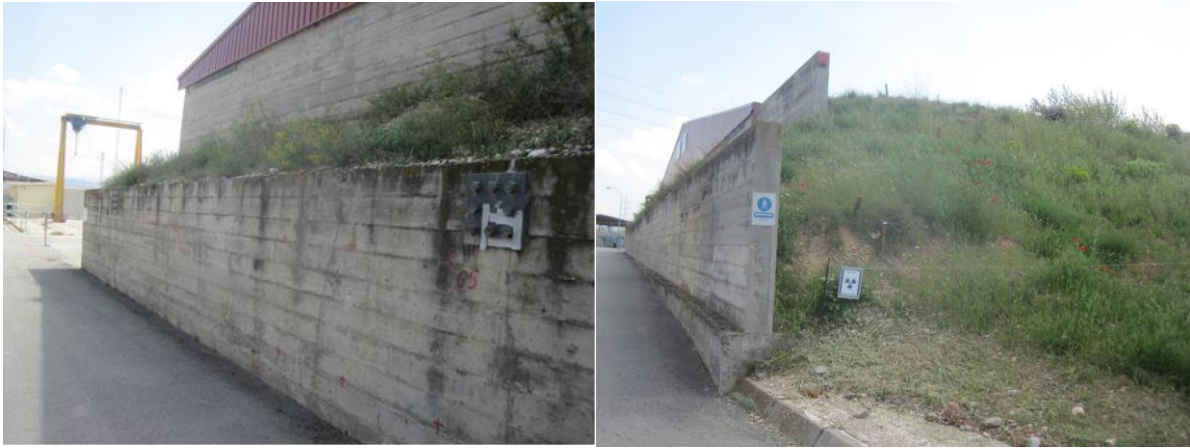
Figura 14. Detalle muro contención norte
