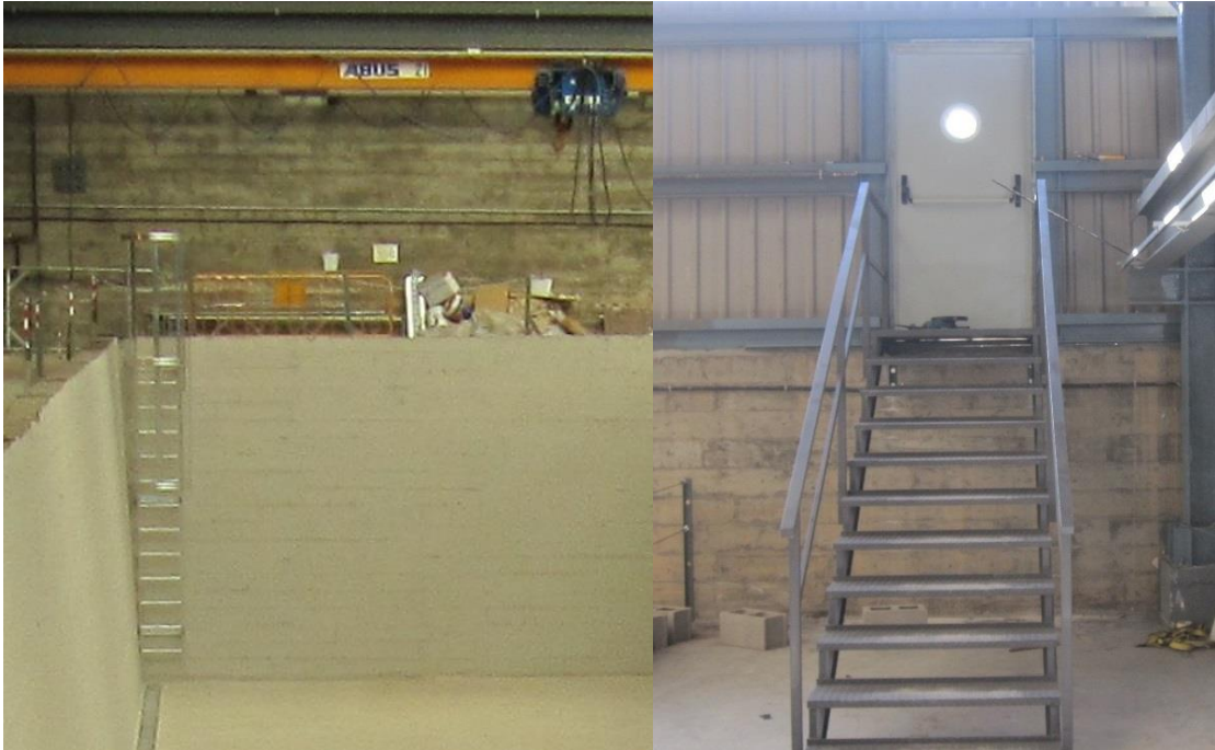
Figura 4 – Escaleras interiores. Escalera de acceso a fosa (izquierda) y escalera acceso sur (derecha)
