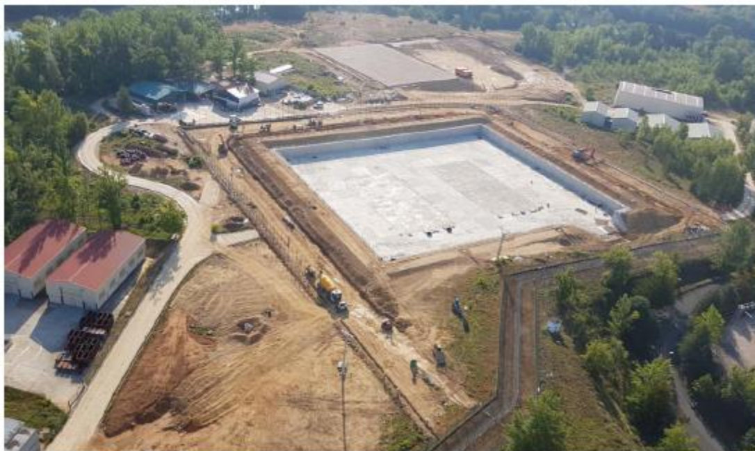
Figura 2. ATI ya construido
