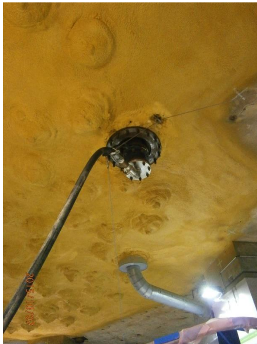
Foto 4. Penetración de presurización: E7N20. Manguera sujeta al enganche de izado.
