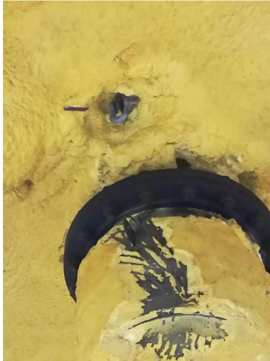
Foto 5. Detalle del gancho de izado de la penetración de presurización: E7N20, con un grillete.
