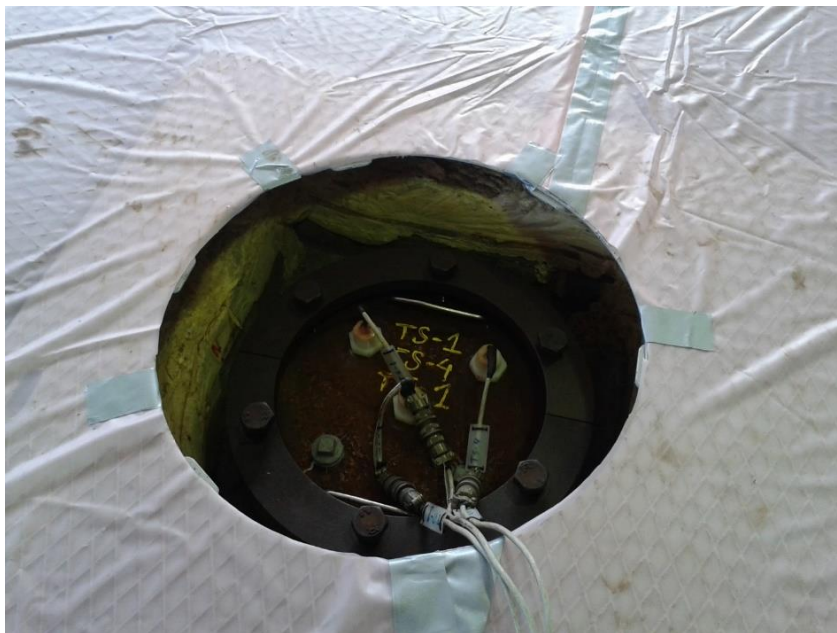
Foto 8. Penetración de instrumentación de temperatura F4M2.
