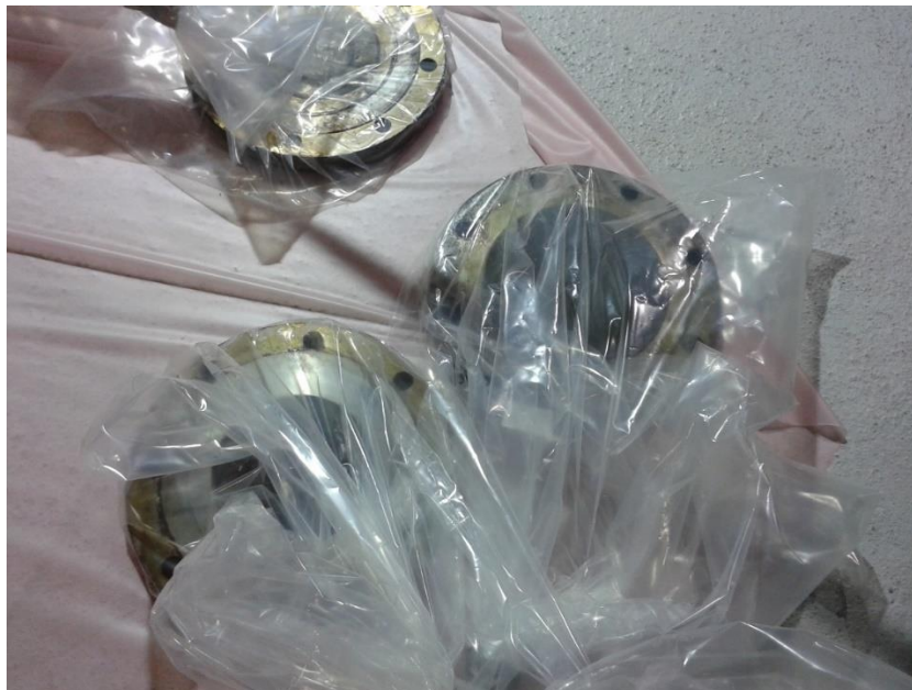
Foto 2. Bridas de los tapones de las penetraciones de la cava
