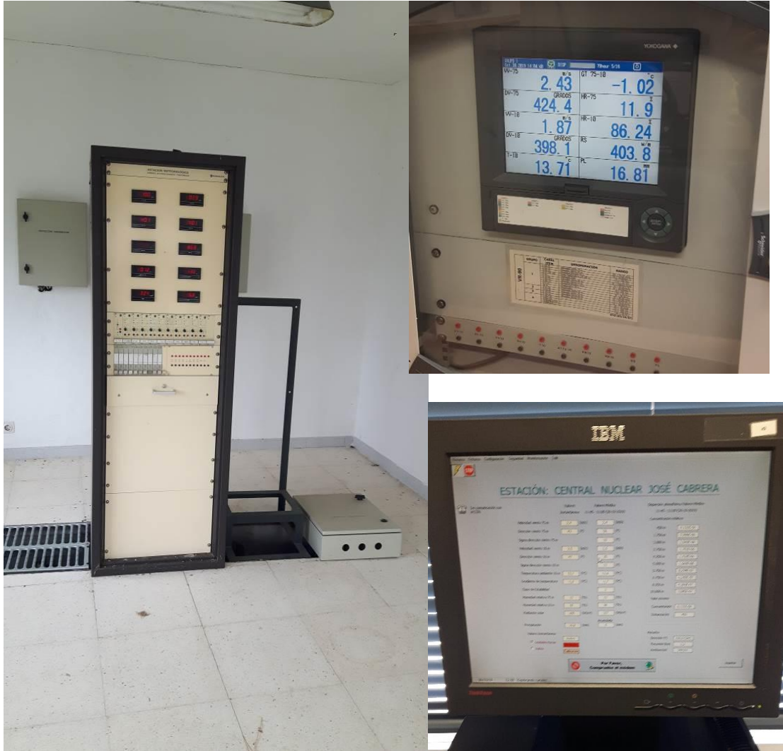
Foto 4 – Armarios de transmisión y PC de visualización
