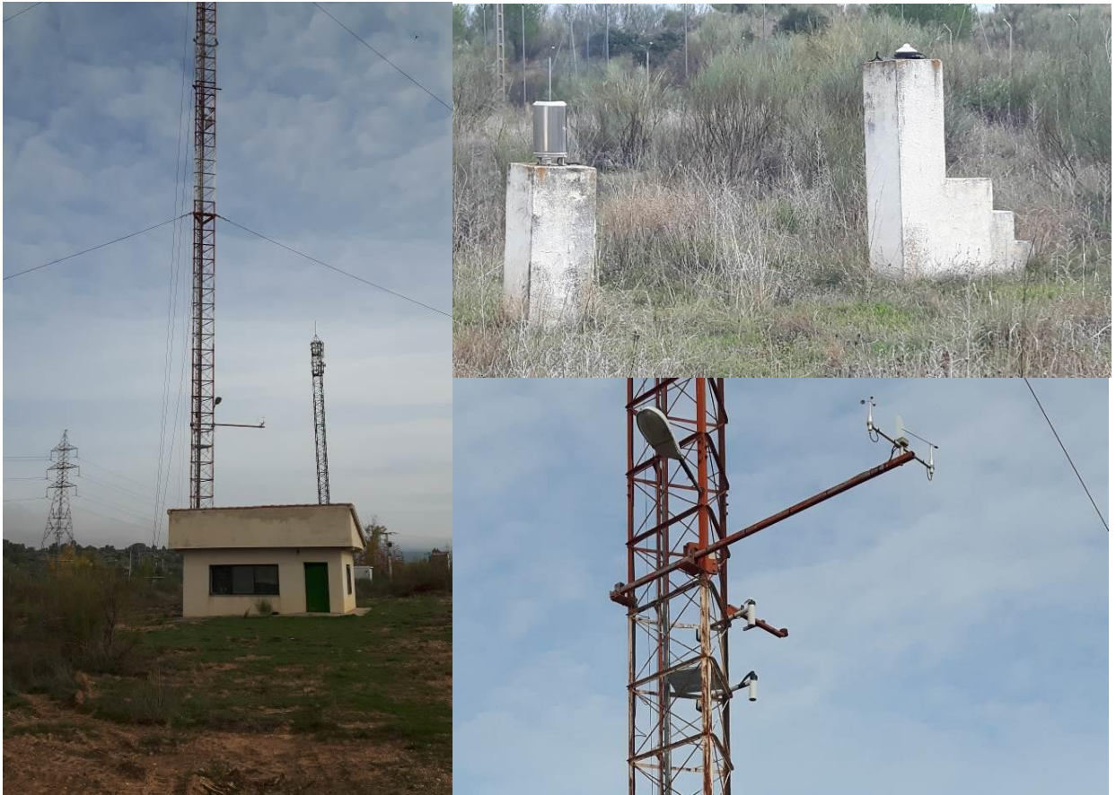
Foto 5 – Detalles caseta e instrumentación
