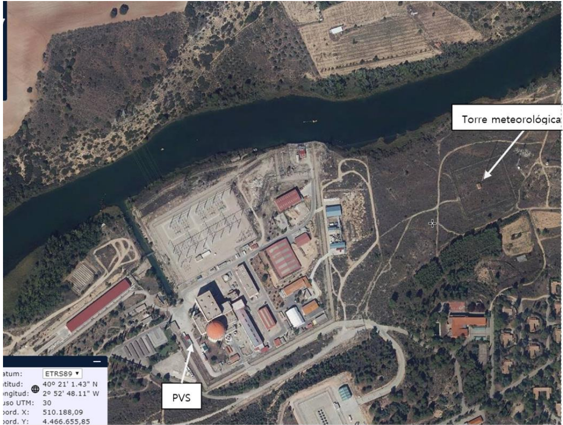
Foto 1 – Vista aérea del emplazamiento
