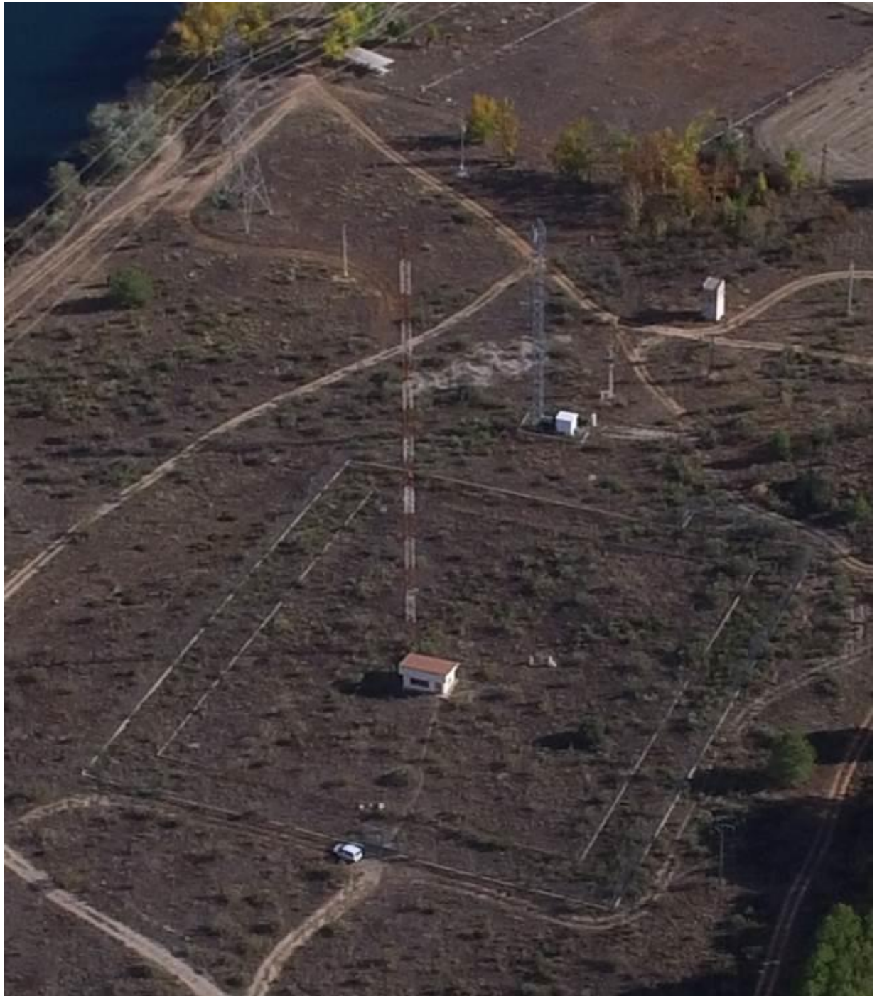
Foto 3 – Detalle torre meteorológica y de telefonía (detrás)
