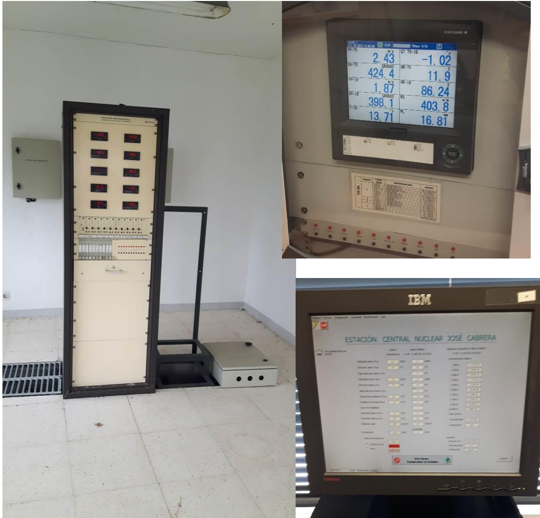
Foto 4 – Armarios de transmisión y PC de visualización
