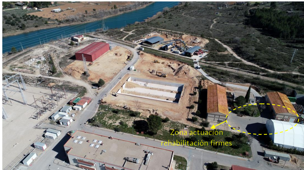
Figura 17 – Zona de actuación para rehabilitación de firmes
