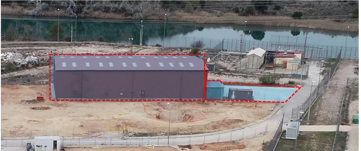
Figura 41. Almacén 3 y otros elementos a demoler
