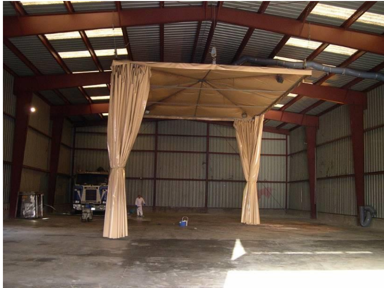
Figura 3. Vista interior Almacén 3
