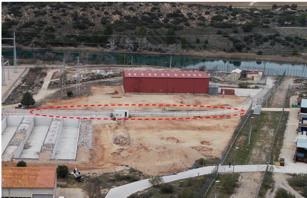
Figura 13. Vial de acceso a toma de agua.
