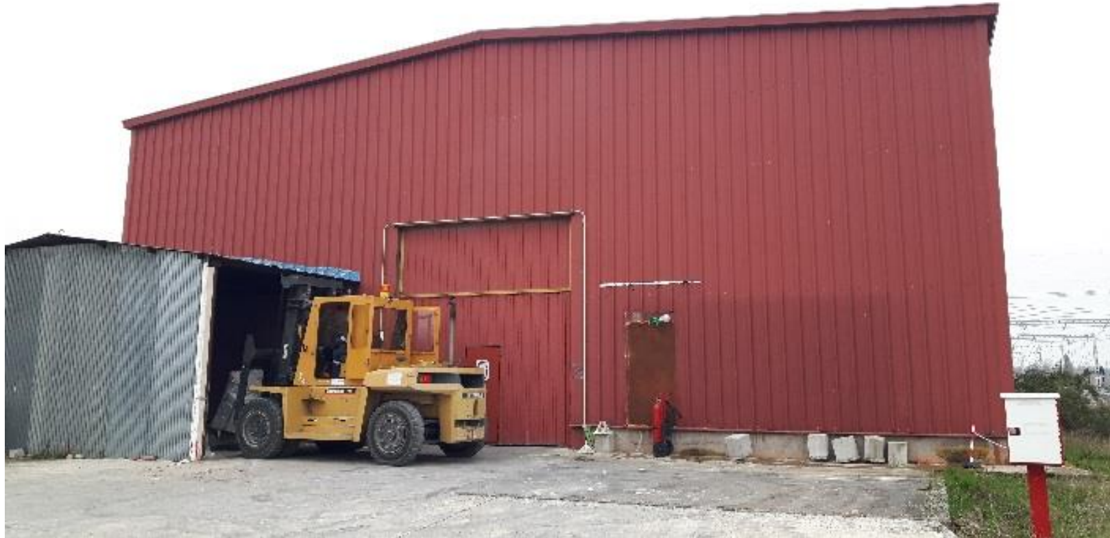
2.-Fotografía Almacén 3. Acceso
