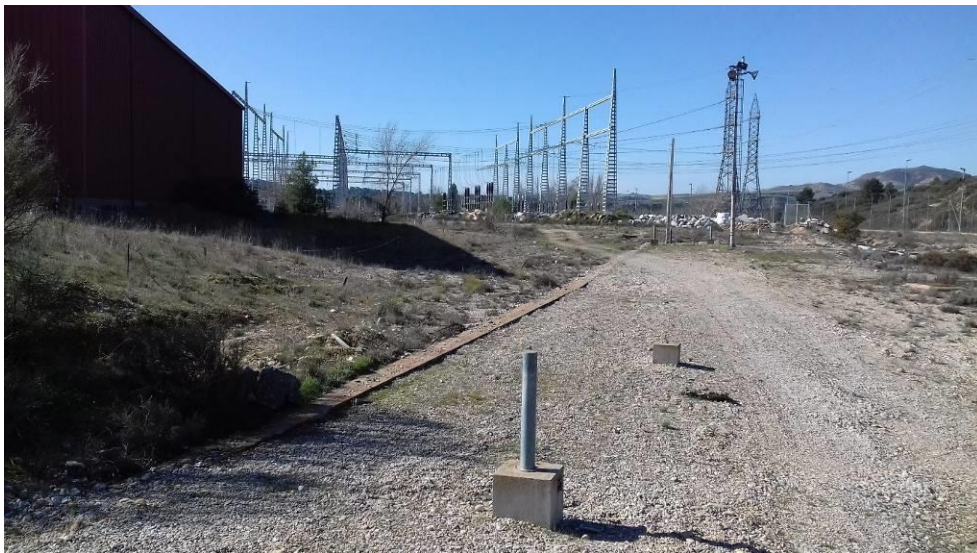
Figura 21 – Zona norte del Almacén 3 (antiguo doble vallado de toma de agua)
