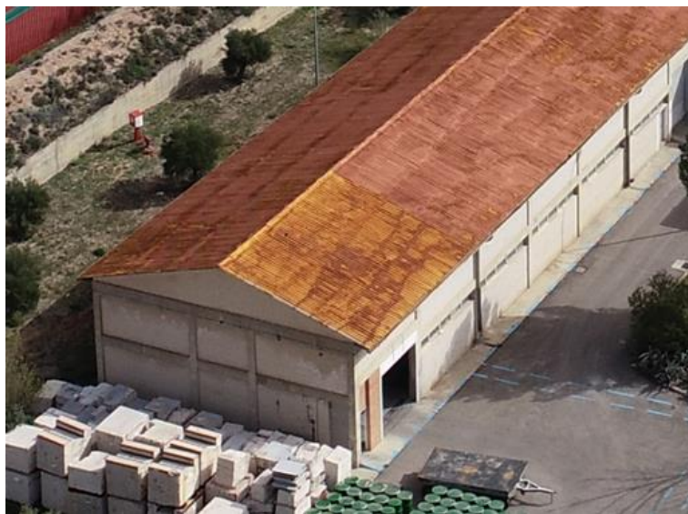
Figura 43. Fotografía aérea de cubierta del almacén de desclasificables
