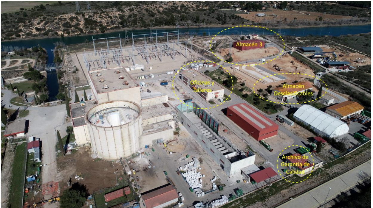
Figura 1. Ubicación principales edificios a desmontar/demoler y excavaciones.
