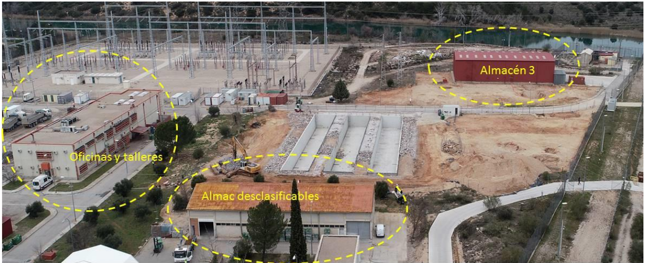
Figura 15. Edificios a demoler
