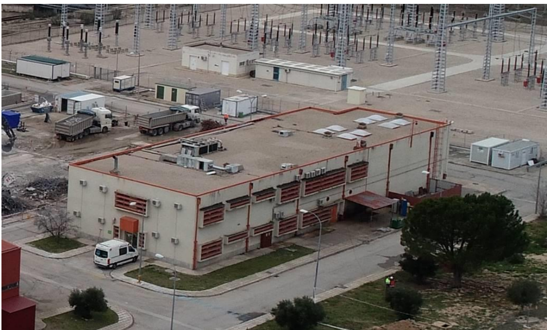
Figura 46. Fotografía aérea de oficinas y talleres
