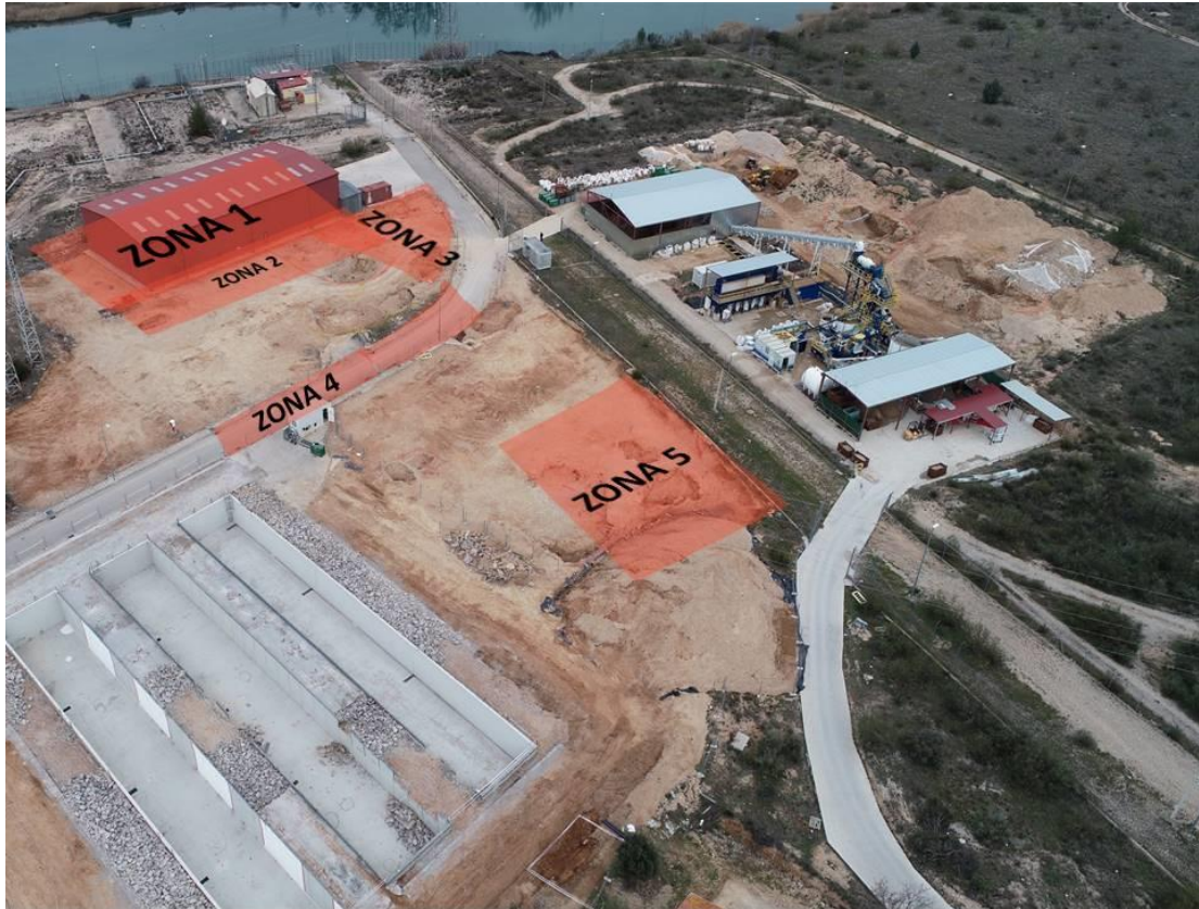
Figura 18 – Zonas de excavación
