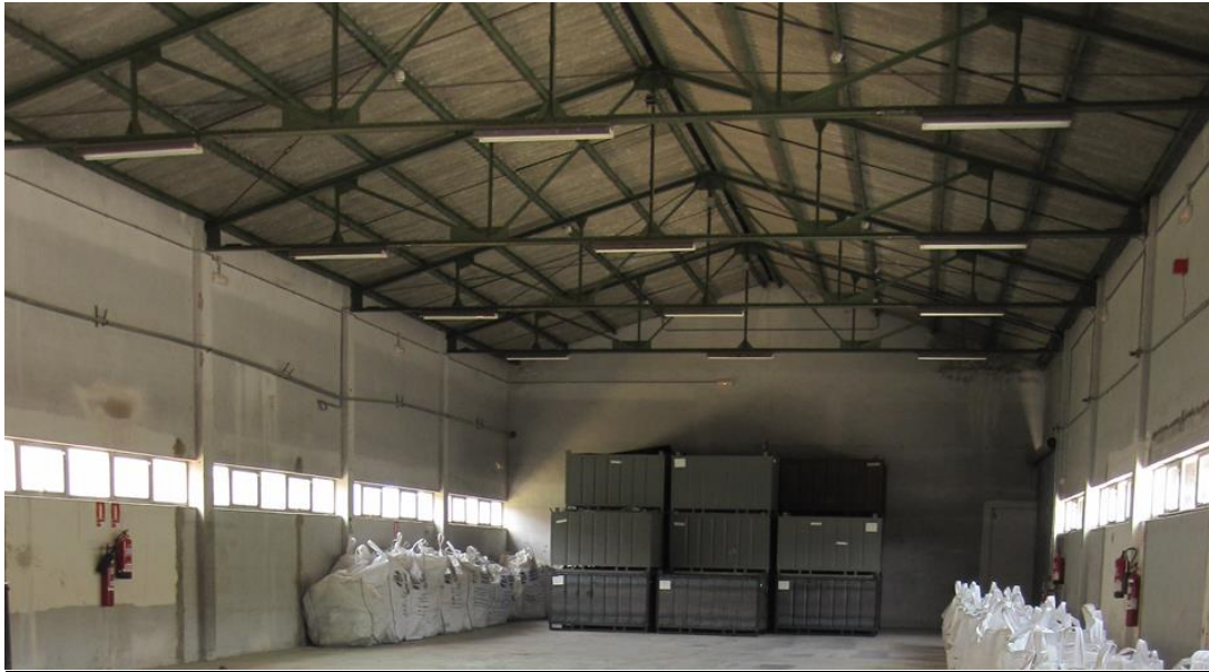
Figura 44. Detalle de estructura de cubierta del almacén de desclasificables
