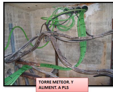
11.- Interferencias. Detalle de Arqueta TR-9 de canalizaciones eléctricas
