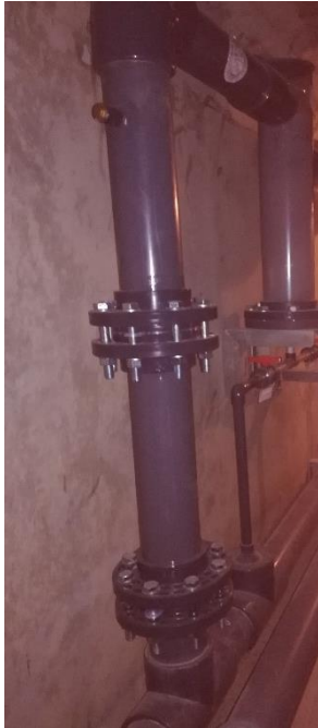
Foto1-2.-Carrete desmontable y picaje
