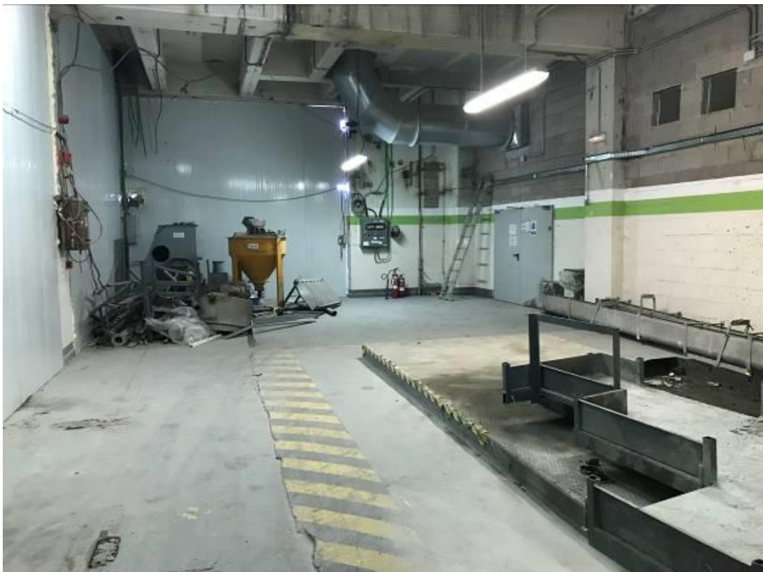
Figura 42.- Tolva, Rompesacos y elementos achatarrables frente al local de ventilación nivel 609,200
