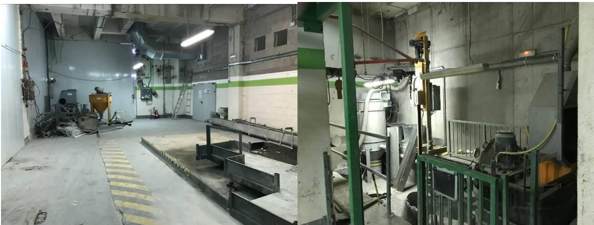
Figura 19.- Planta de fabricación de mortero. Estado actual (semi-desmontado)
