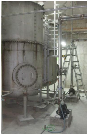
Figura 10. Tanques A/B, depuradora compacta DC-1 y planta de filtración
