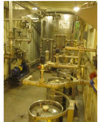
Figura 10. Tanques A/B, depuradora compacta DC-1 y planta de filtración
