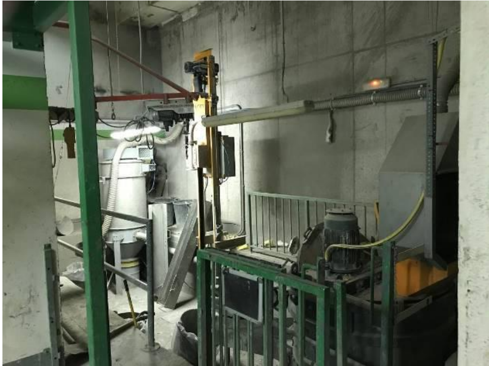
Figura 43.- Sistemas de inyección (inmovilización y sellado) en plataforma elevación 608,200.
