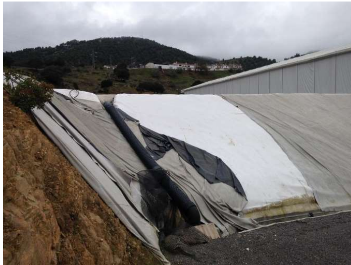
Fotografía 4. Impermeabilización del caballón de tierras
