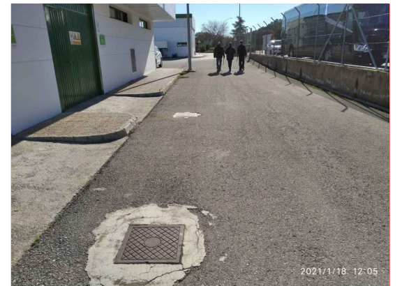
F-9 Zona por la que discurre la tubería delante del edificio de Contratistas Eventuales
