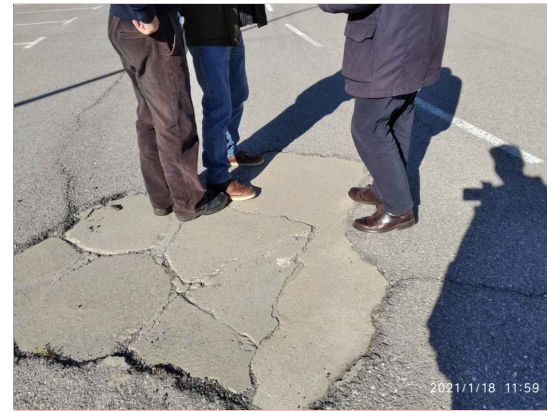
F-4 Reparación realizada por fuga en la curva del Edificio de Talleres
