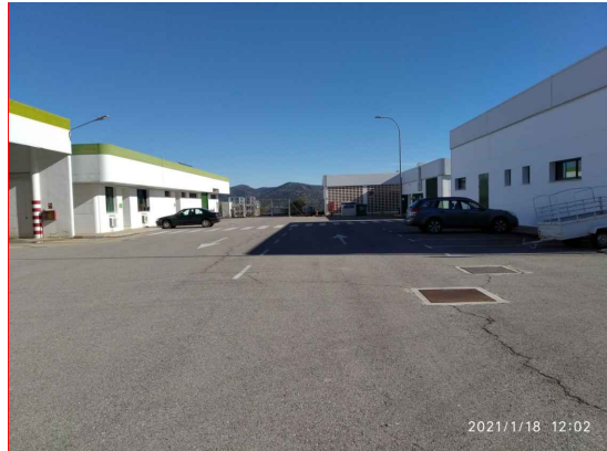
F-6 Calle de Hangar y Edificio de Contratistas Habituales
