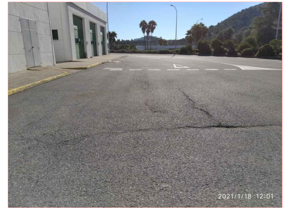
F-5 Zona de trazado de la tubería delante de los Edificios de Talleres
