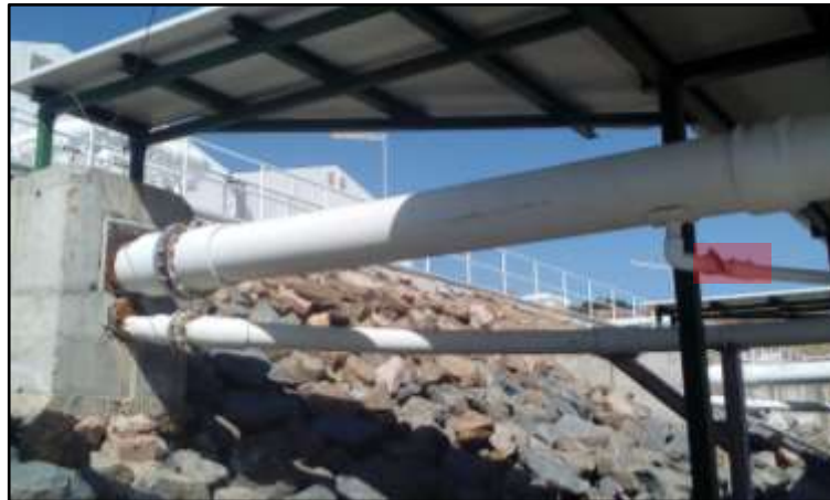
Figura 5-8. Tramo de la Línea de Explotación 1 de la Sección I para desmontar
