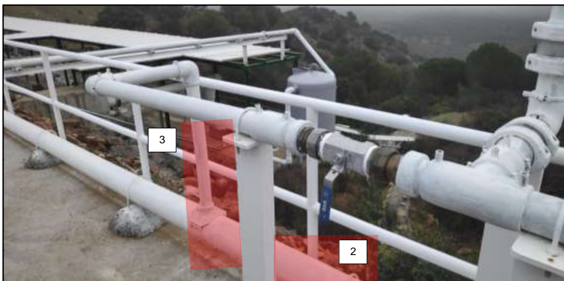
Figura 5-2. Tramos de la Línea de Explotación 1 de la Sección II para desmontar
