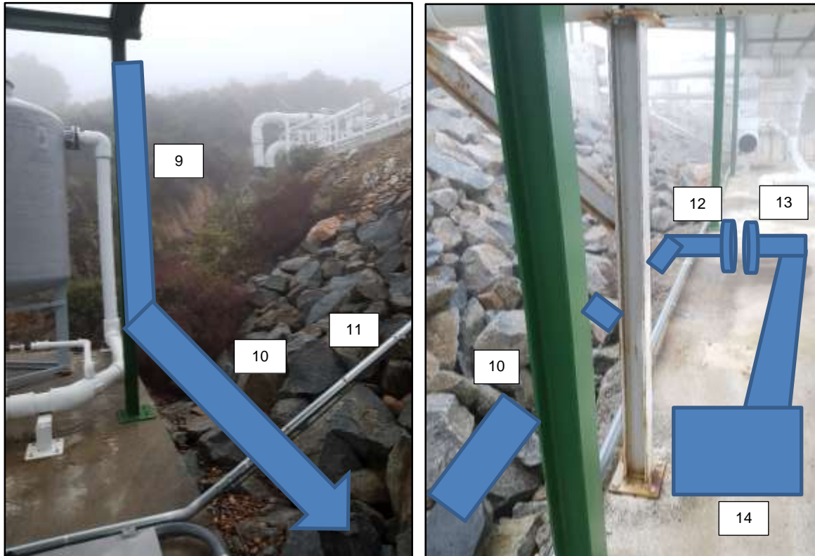
Figura 5-4. Trazado nuevos depósito y colectores lixiviados para RRL-1 en Línea de Explotación 1, Sección II
