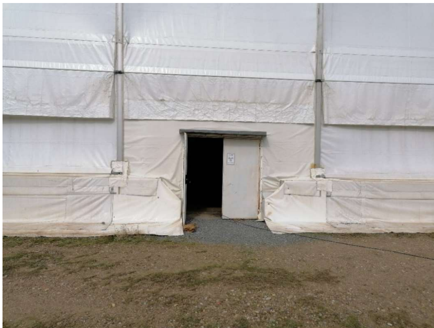
Foto 2. Puertas en el fondo del vaso que se desmontan, pórticos 12 - 13 y 5 - 6.
