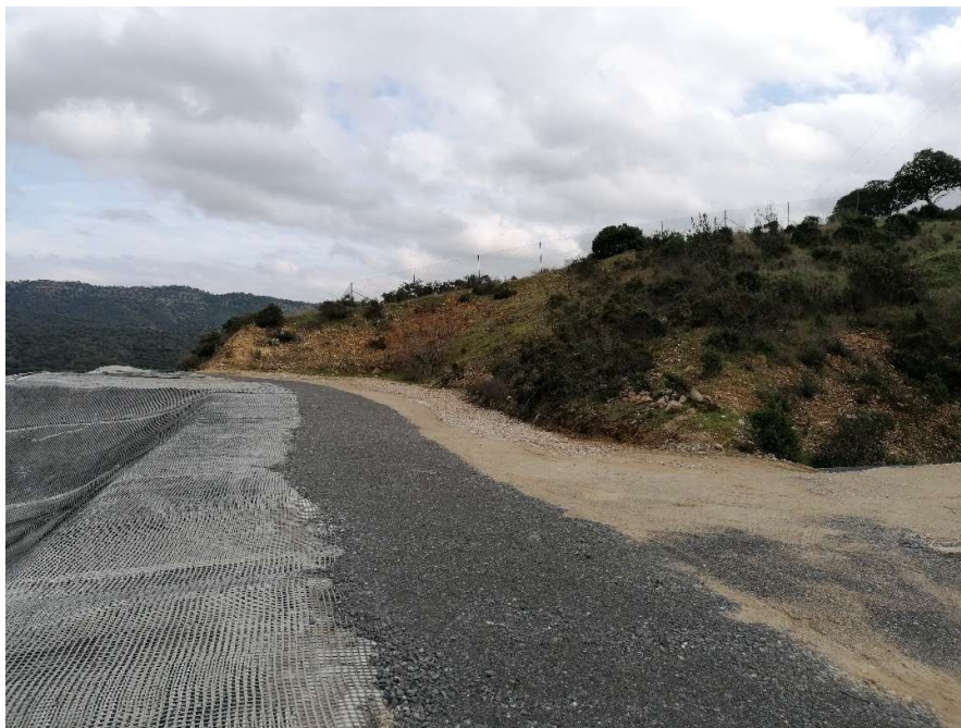
Foto 14. Zona de talud sureste.
