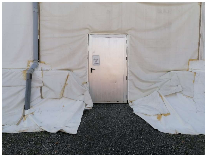
Foto 3. Puertas en la cara norte cubierta de 20m que se sustituyen.
