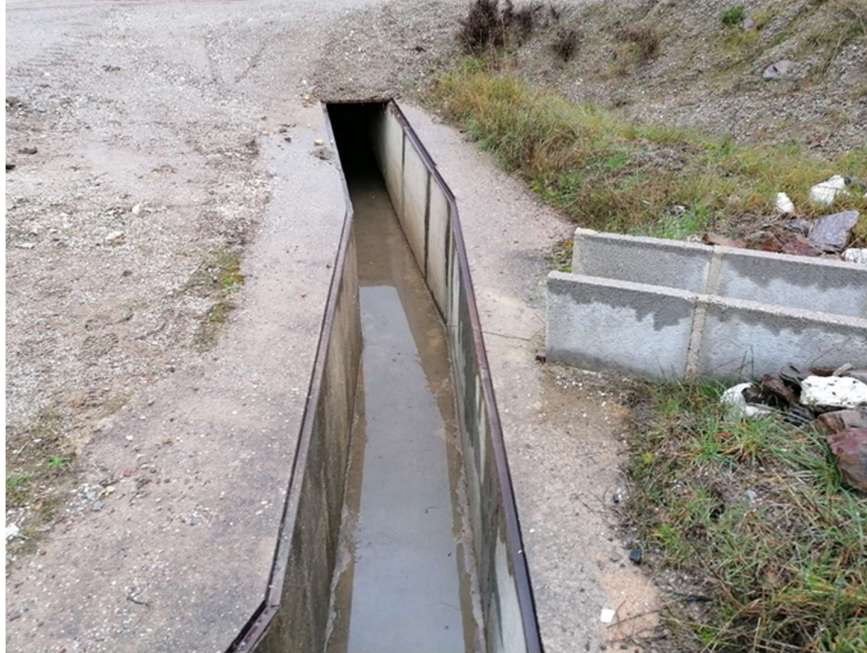
Foto 11. Cuneta existente en zona sur.
