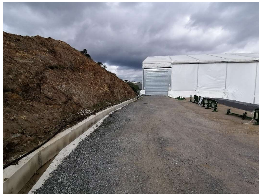
Foto 6. Zona de talud oeste.
