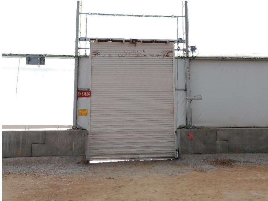
Foto 1. Puerta en el fondo del vaso que se desmonta, pórticos 19 y 20.
