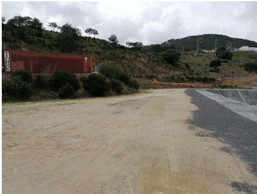
Foto 10. Zona de talud y lado sur, vista de este a oeste.
