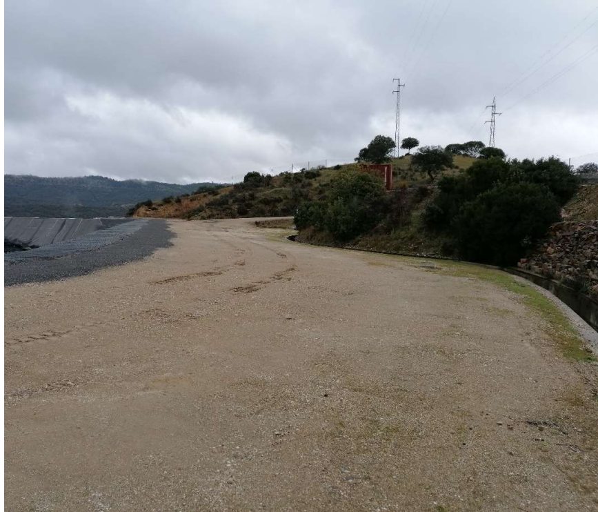
Foto 9. Zona de talud y lado sur, vista de oeste a este.
