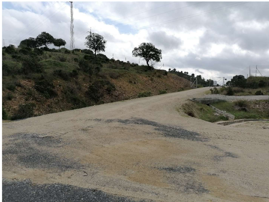
Foto 12. Rampa de acceso de vehículos pesados zona sur.
