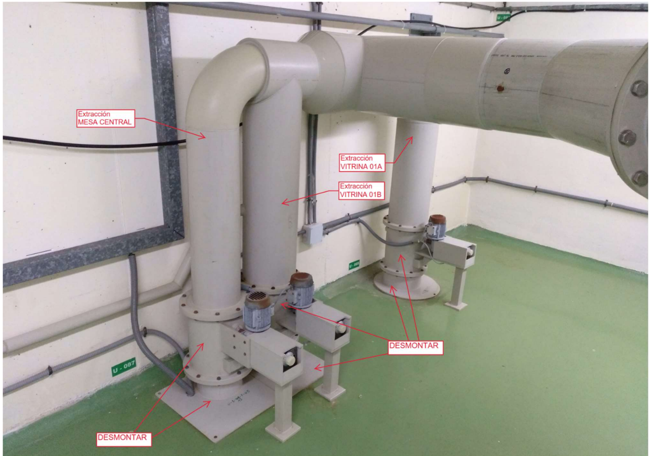
A- 10, Desmontaje de tomas de extracción de vitrinas.
