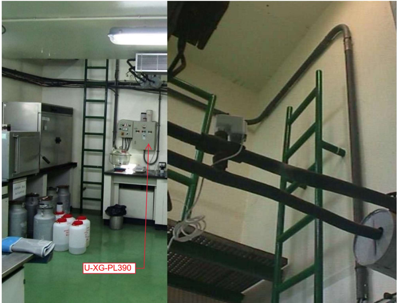
A- 9, Acceso a entreplanta.
