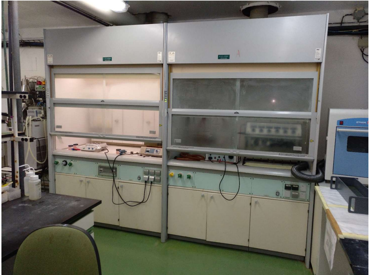
A- 4, Frontal de vitrinas del edificio Laboratorio Activo.
