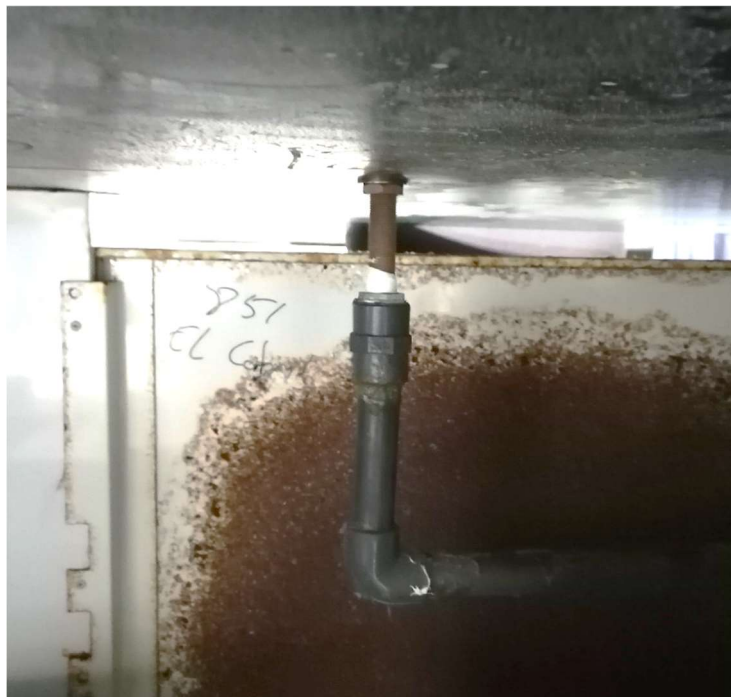
A- 17, Llaves de servicio de vacío actualmente instaladas en mesas de trabajo (arriba, válvulas y colector de doble distribución en mesa, abajo, conexión a tubo PVC).
