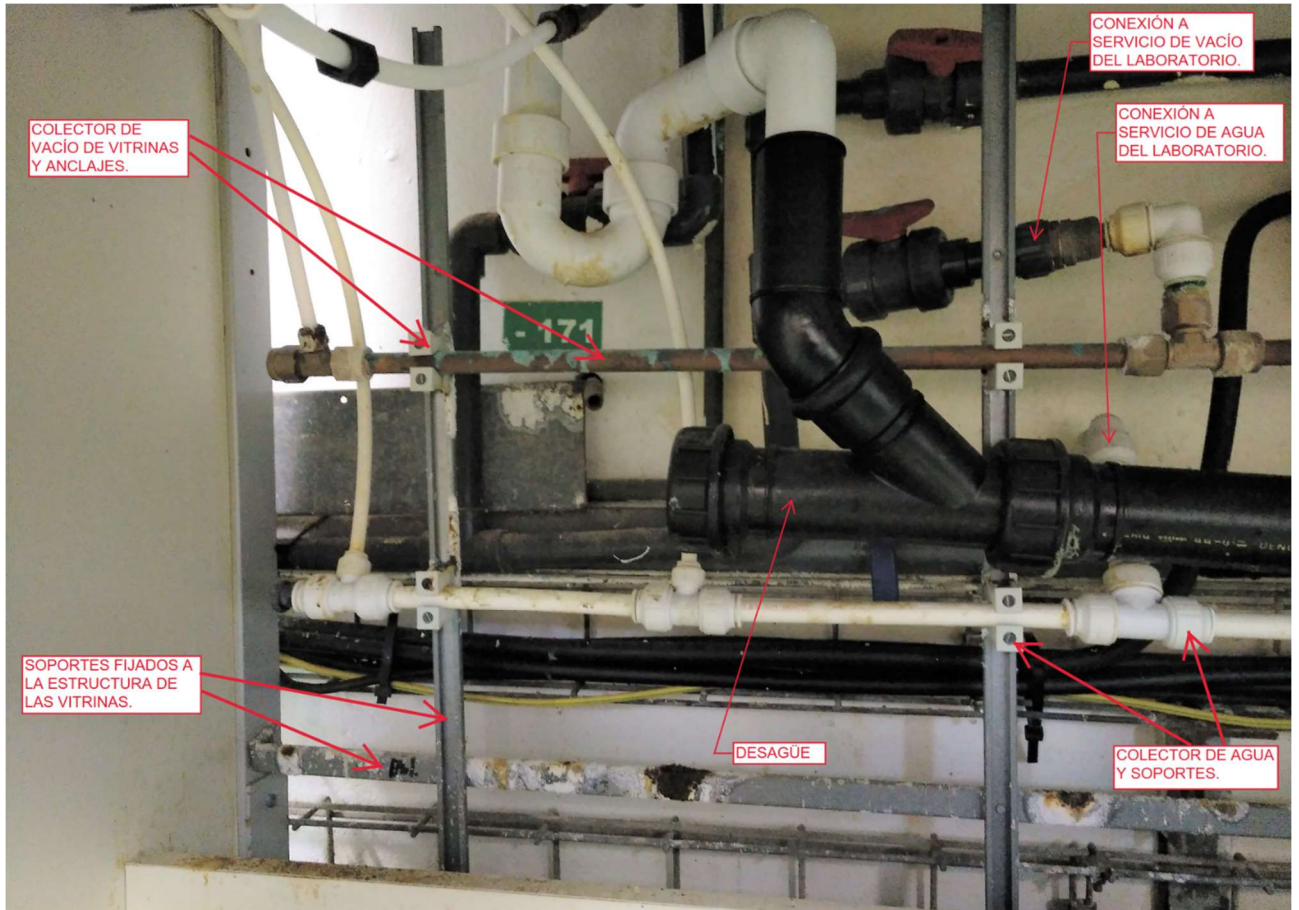
A- 11, Desmontaje de servicios.
