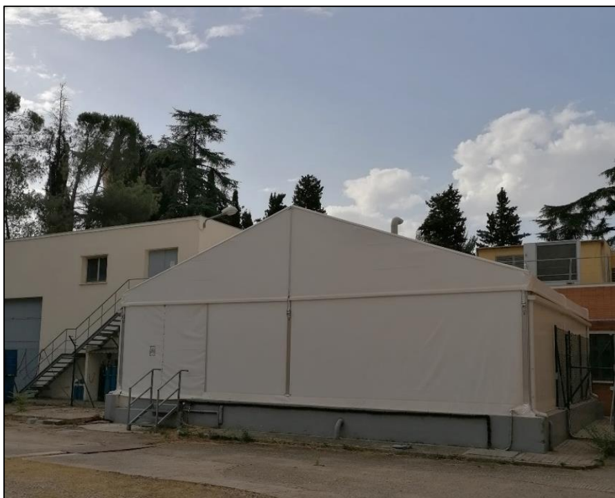
Figura 4. Carpa de la instalación STEL
