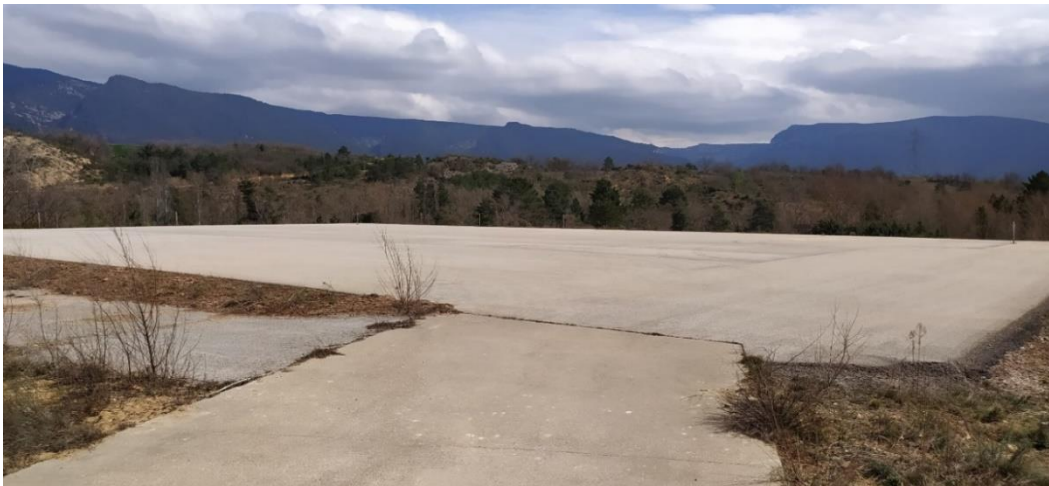
Figura 1-4: Vista general de la explanada del depósito de sobrantes 1
