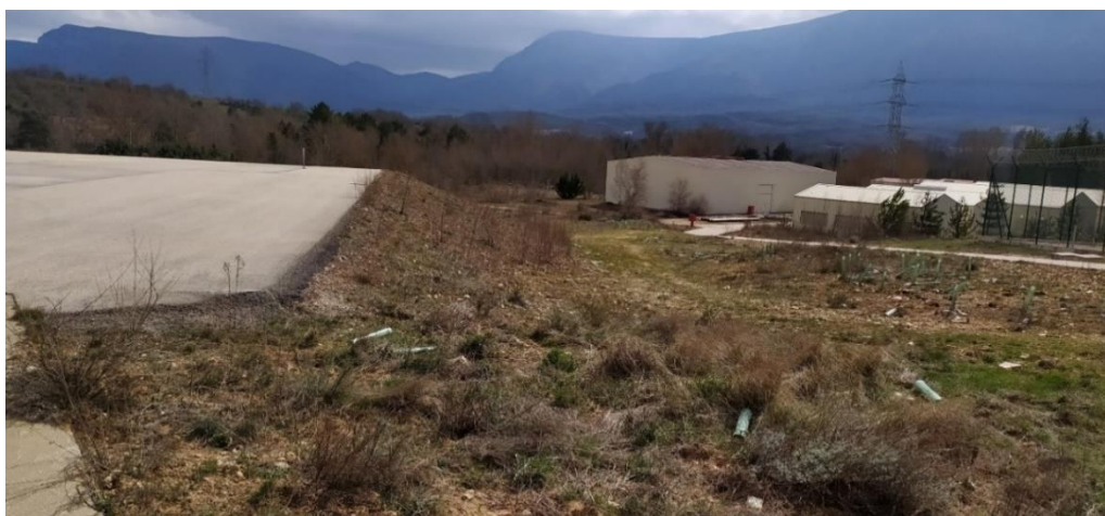
Figura 1-6: Detalle terraplén oeste del depósito de sobrantes 1
