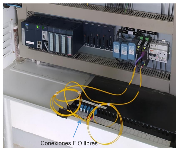
Figura 1-24: Caseta de la torre meteorológica. PNL-3000 conexiones de fibra óptica
