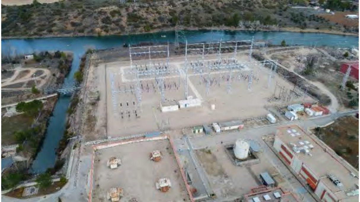
Figura 6 - Vista aérea del Canal de Descarga y desembocadura con el río.
