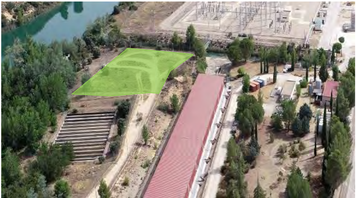
Figura 29. Vista área zona implantación balsa de decantación y punto de muestreo
