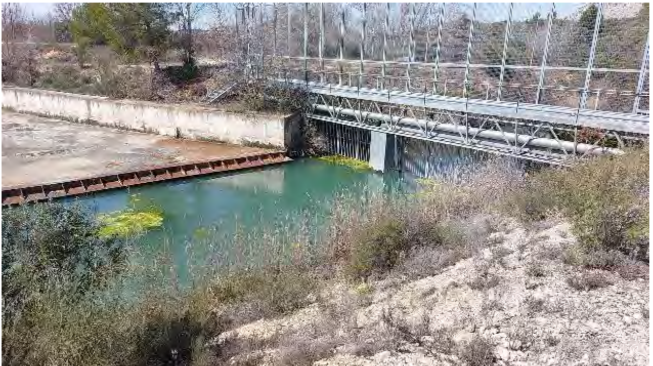
Figura 9 - Pasarela intermedia del Canal de Descarga.
