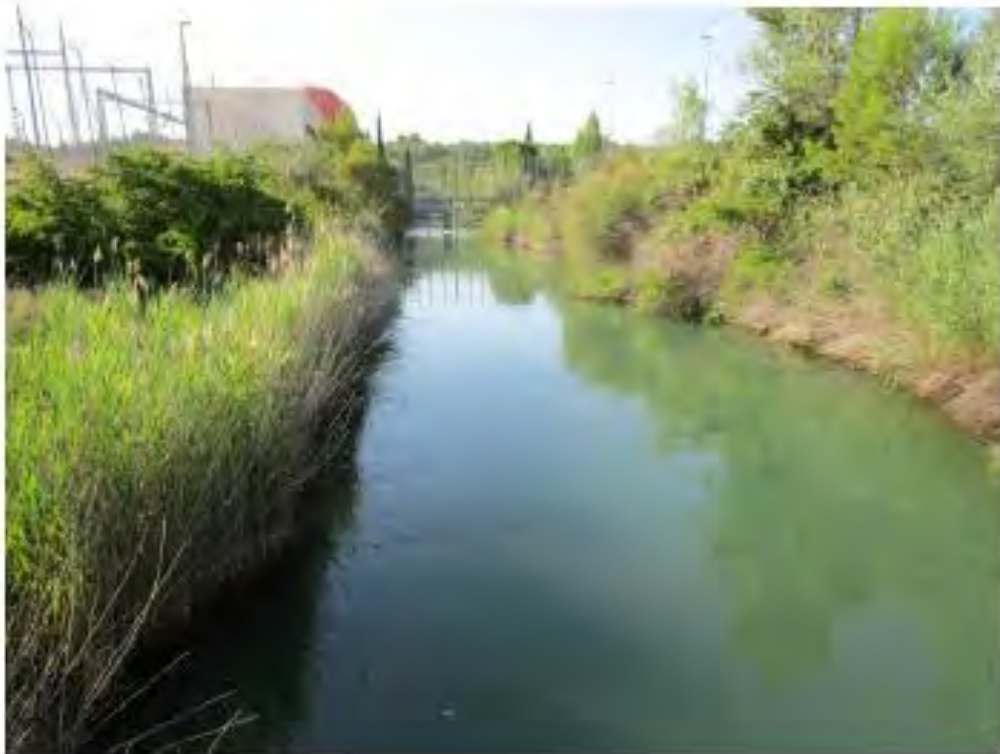
Figura 14 - Vista del Canal de Descarga desde la desembocadura hacia la Central.
