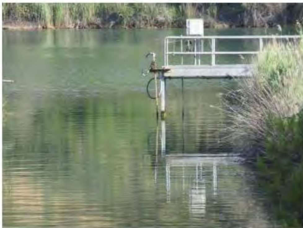
Figura 11 - Semipasarela en la desembocadura del Canal de Descarga.
