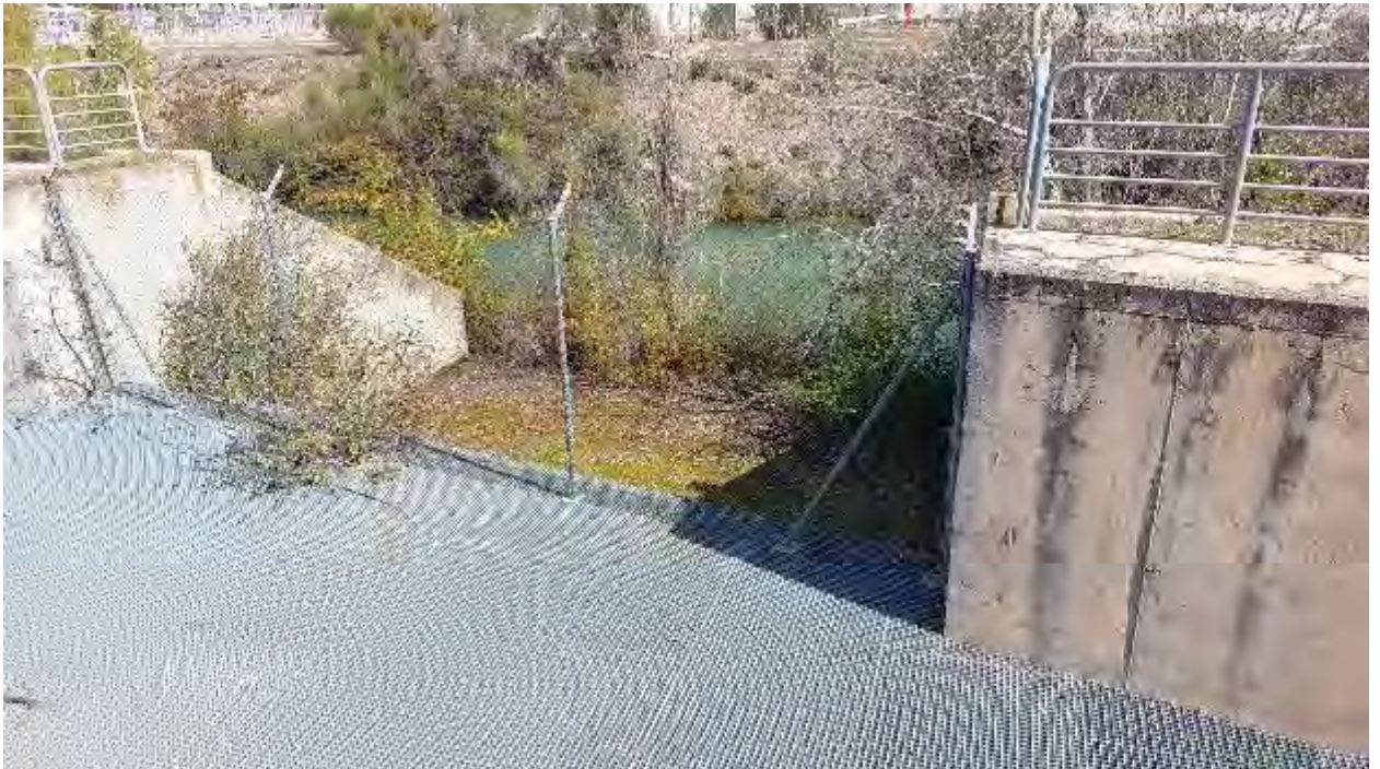
Figura 16 – Vista labio aliviadero Cántara Bombas.
