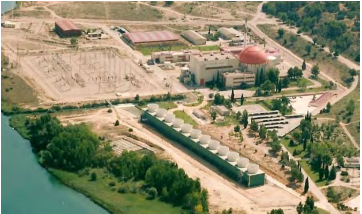
Figura 5 - Vista General Canal de descarga.
