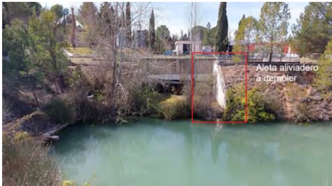
Figura 33.- Aleta del aliviadero de la cántara a demoler
