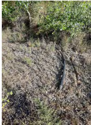
Figura 44.- Prolongación existente de la línea de vertido situada en las inmediaciones de la semipasarela.
