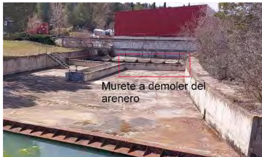
Figura 48.- Murete arenero a demoler.
