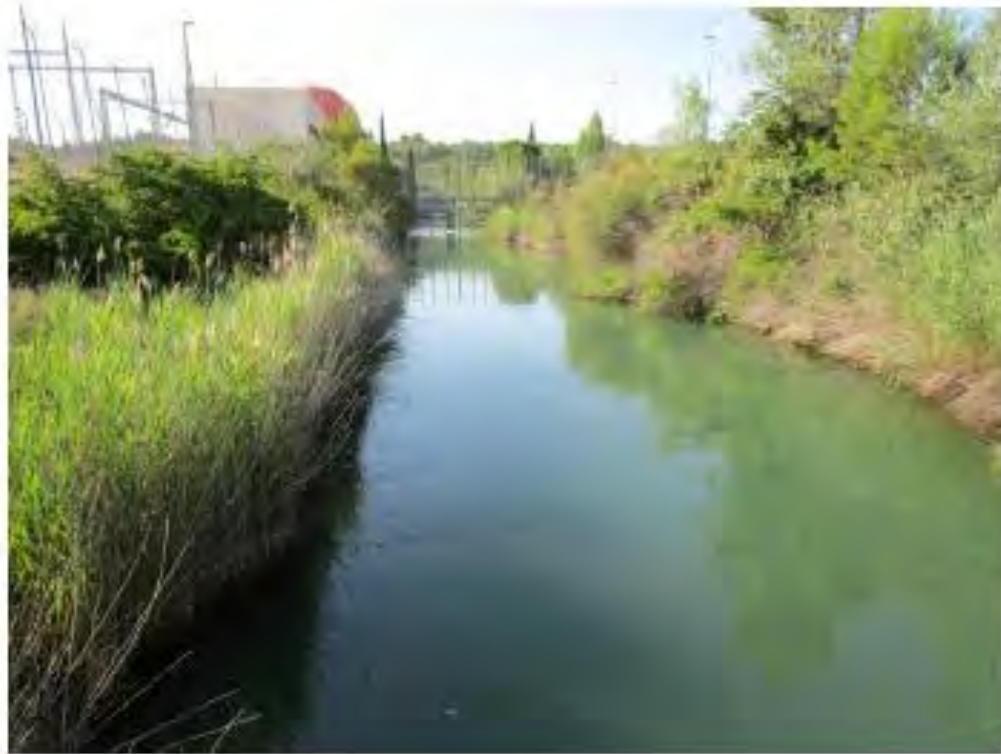
Figura 4 - Vista del Canal de Descarga desde la Pasarela Intermedia hacia la Central.
