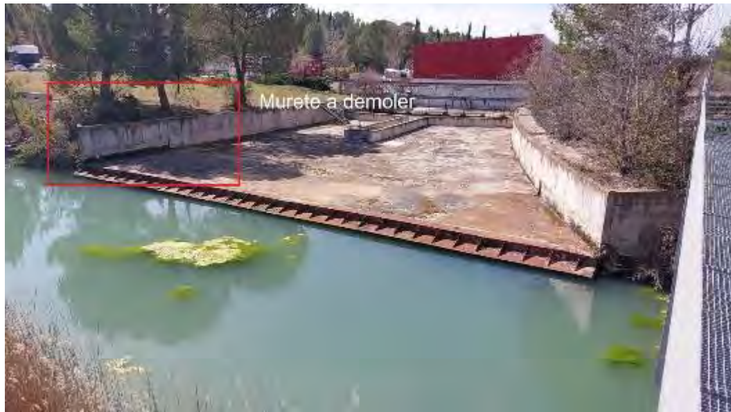
Figura 32.- Muro del canal de antiguas torres de refrigeración a demoler
