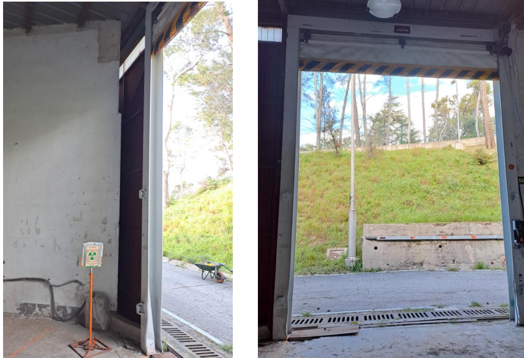
Figura 11. Fotos de zona interior del local D del edificio 64
