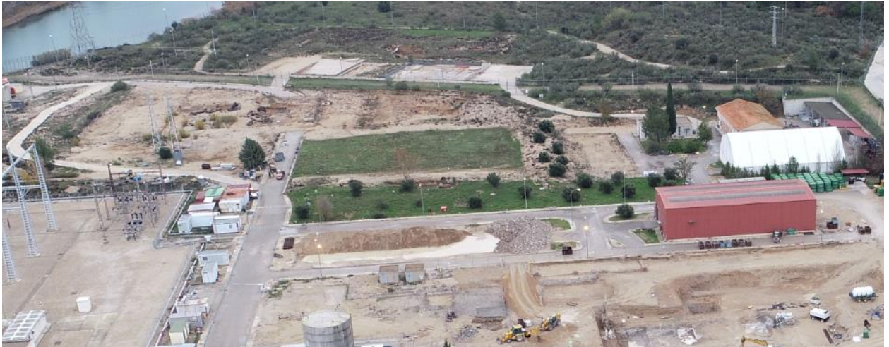
Figura A.1. Estado actual de la zona este del emplazamiento
