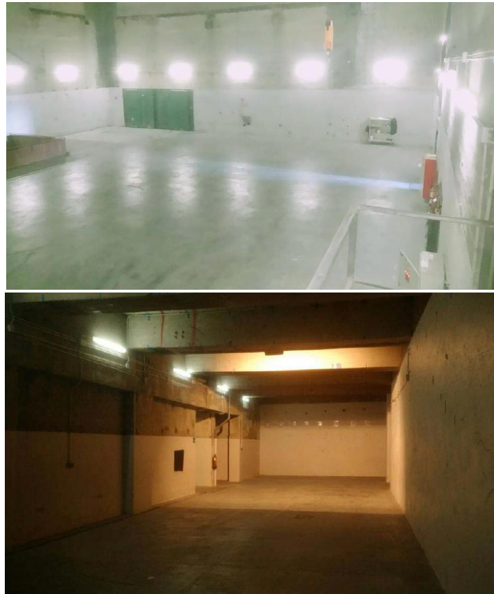
Figura 3. Estado actual del Edificio E-11 Nave (arriba) y del sótano del edificio (abajo).
