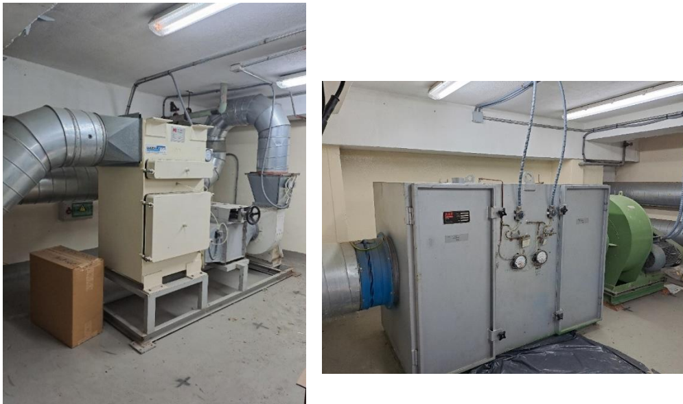
Figura 6. Estado actual del Edificio E-11 Torre.
