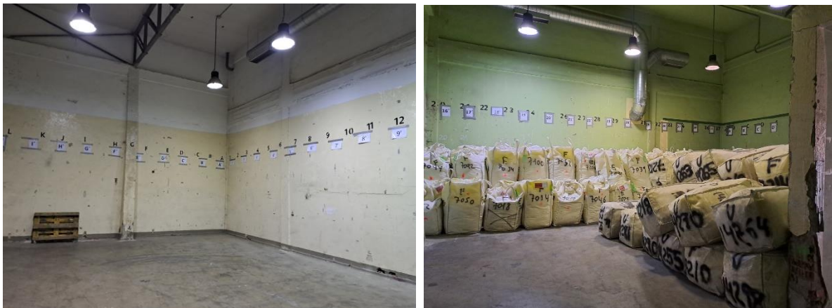
Figura 4. Estado actual del Edificio E-11 Anexo.
