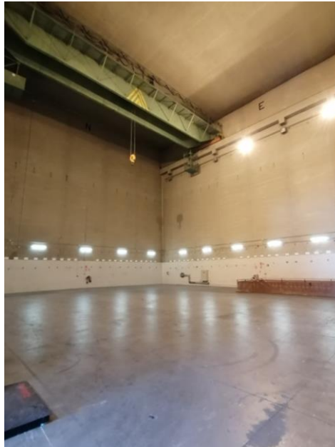
Figura 14. Vista actual Edificio E-11 Nave
