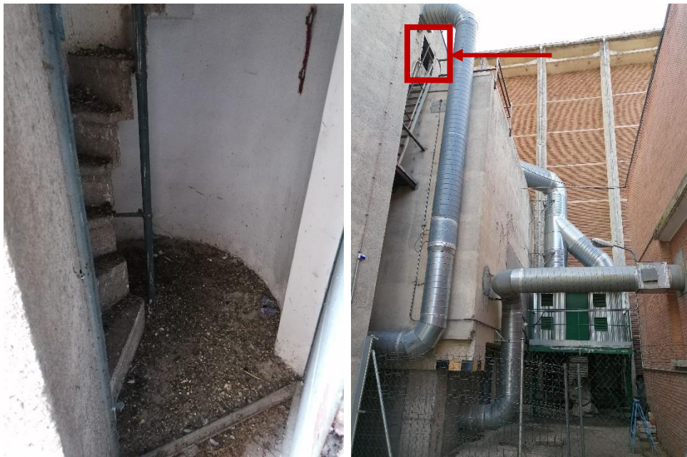
Figura 15. Zona de limpieza de restos orgánicos. Escalera de acceso a la chimenea (izquierda) y cubierta del Edificio E-11 Torre (derecha).
