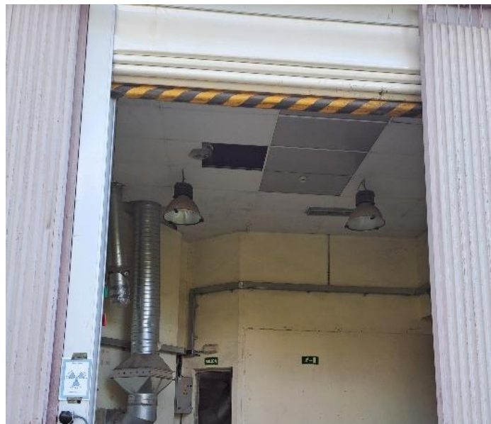
Figura 16. Fotografía del falso techo del Local C del Edificio E-64.
