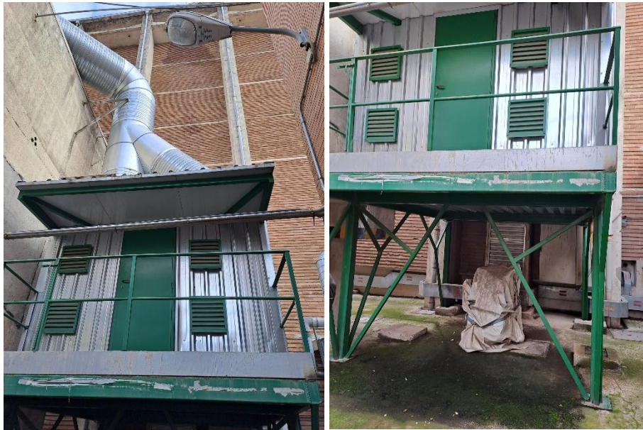
Figura 18. Fotografía de la caseta de ventilación a desmantelar.
