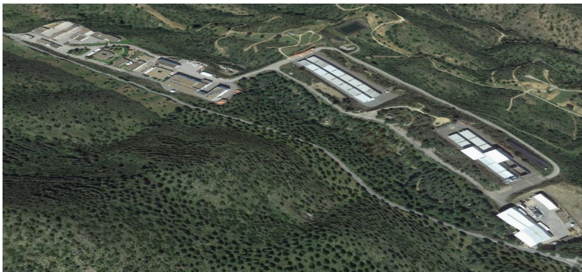
Ilustración 1. Fotografía aérea de El CABRIL.
