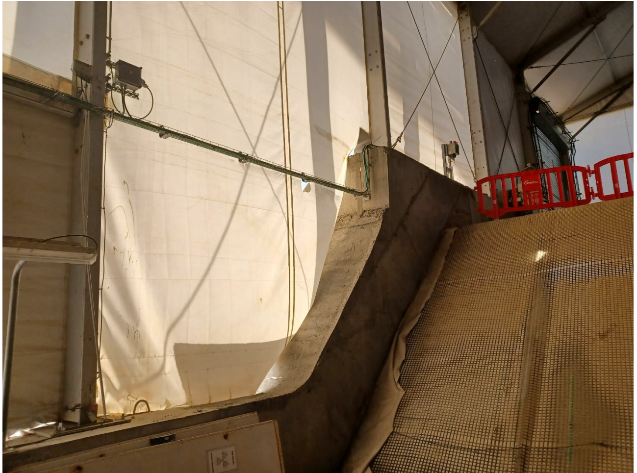
Figura 8 Travesaño mediante perfil de tubo cuadrado de acero galvanizado para salvar espacio entre pórticos
