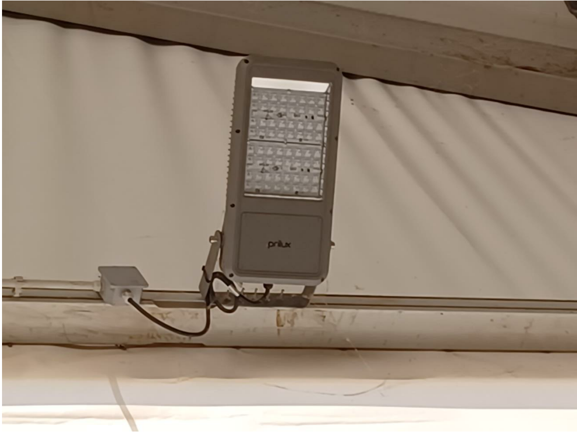
Figura 15 Detalle instalación proyector existente
