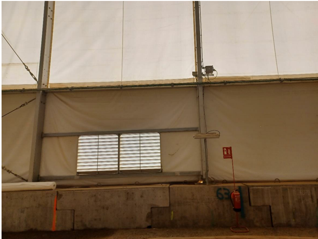
Figura 7 Detalle instalación existente de bandeja en altura
