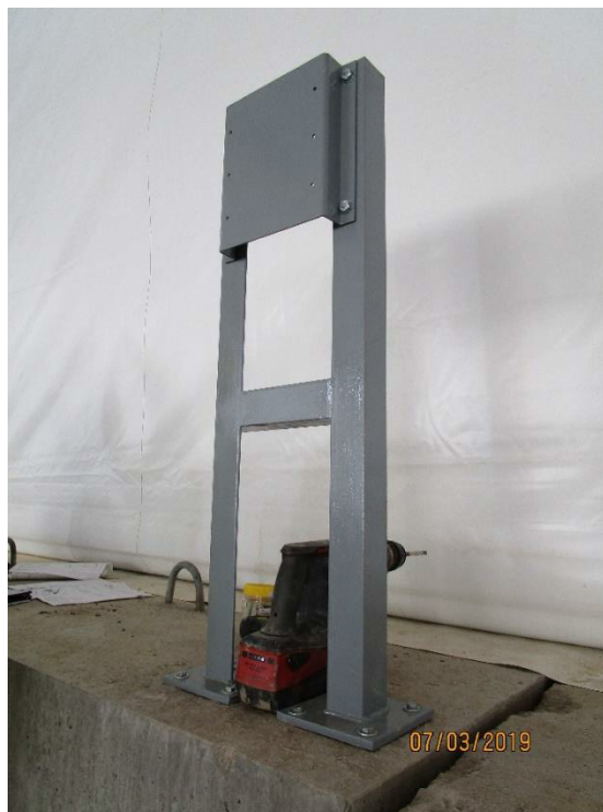
Figura 23 Soporte y placa de fijación para monitor de radiación
