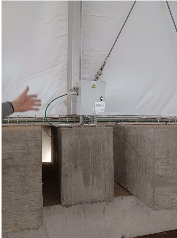
Figura 9 Instalación de bandeja pegada al pilar y equipos auxiliares por el exterior de la zapata
