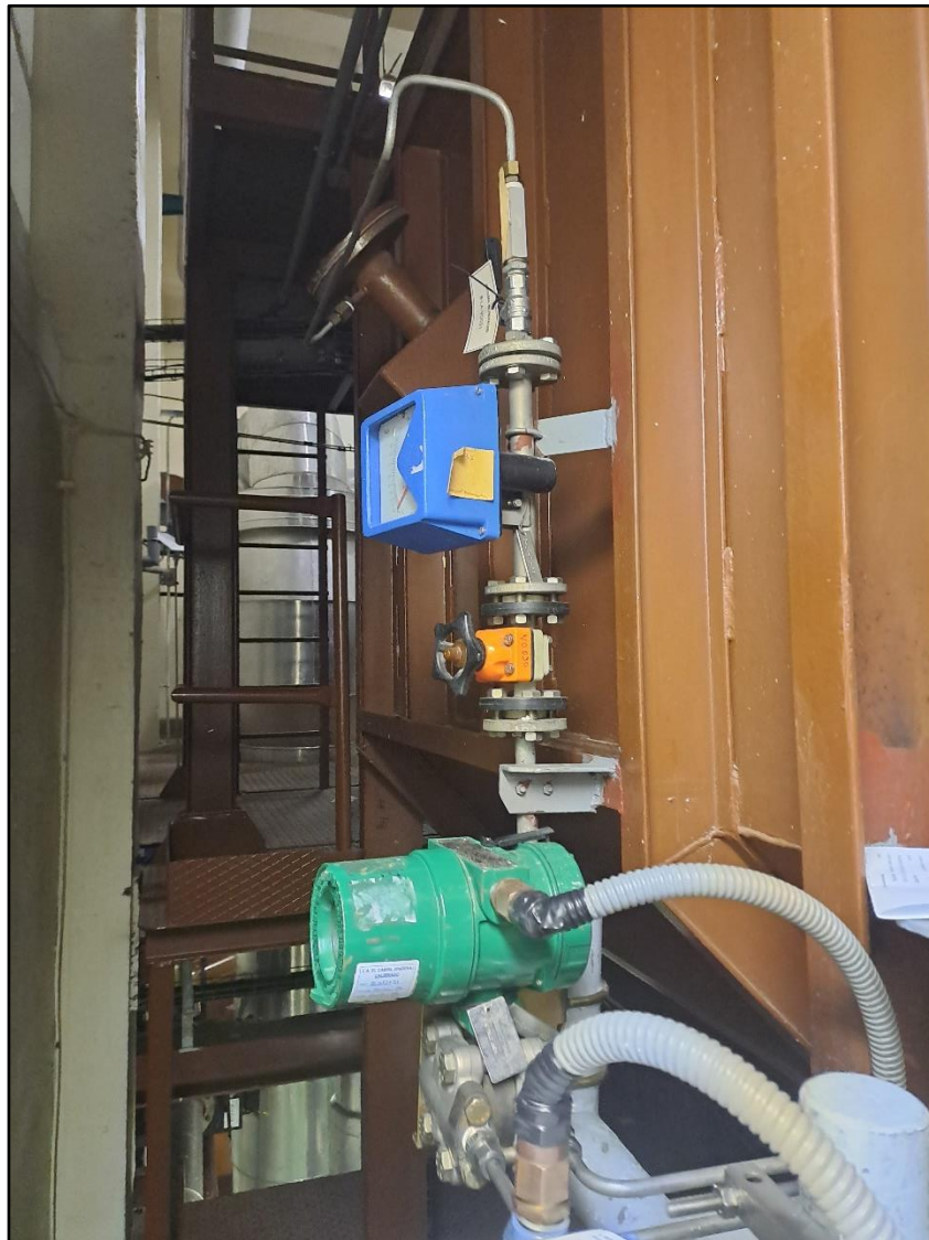
Foto 3.2. Sustitución sistema aire comprimido incinerador
