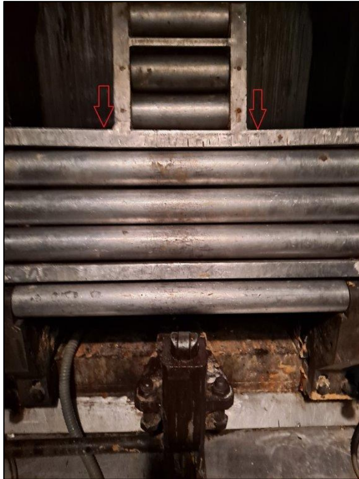
Foto 2.2. Sustitución sistema volteo de galletas de compactación
