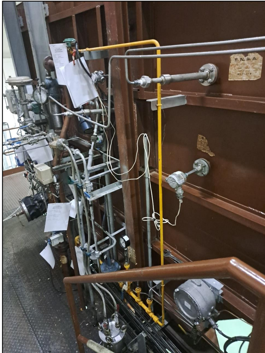
Foto 3.1. Sustitución de los quemadores del incinerador
