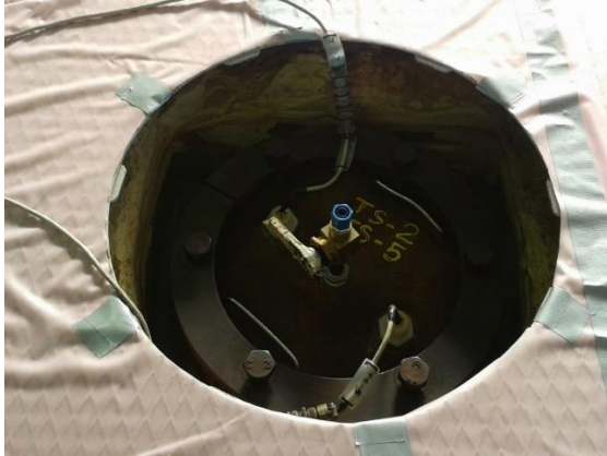
La penetración de instrumentación de temperatura F4M20
