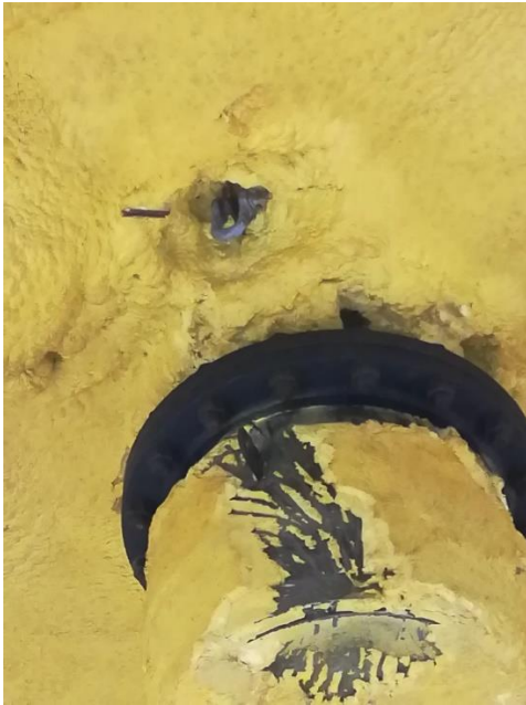
Detalle del gancho de izado de la penetración de presurización: E7N20, con un grillete
