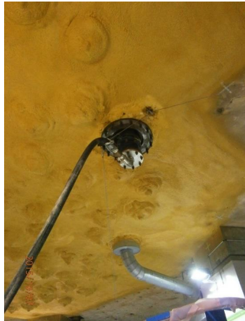
La penetración de presurización: E7N20. Manguera sujeta al enganche de izado.
