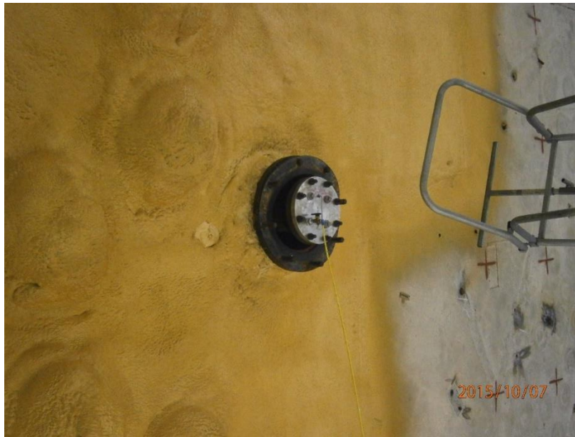
La penetración para lectura de presión E19N2
