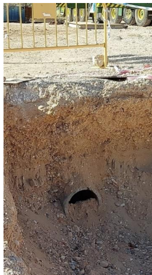
Figura 3.- Tubería de evacuación de pluviales enterrada
