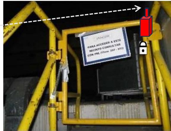
Fotografías 23 y 24: Disposición de los equipos de bloqueo del puente grúa
