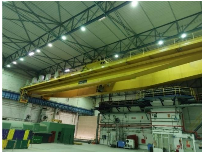
Fotografía 1: Vista general del puente grúa
