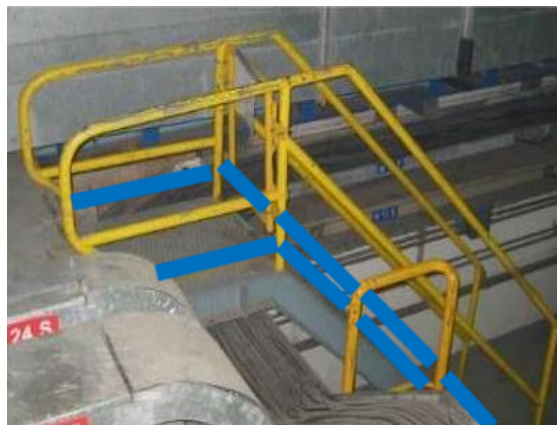
Fotografía 17: Rodapié (marcado en color azul) a instalar de acceso a la parte alta de la grúa
