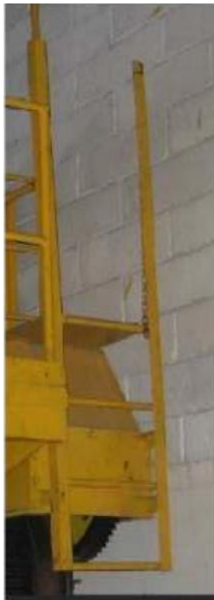
Fotografía 22: Asideros existentes del acceso a la escalera de la grúa
