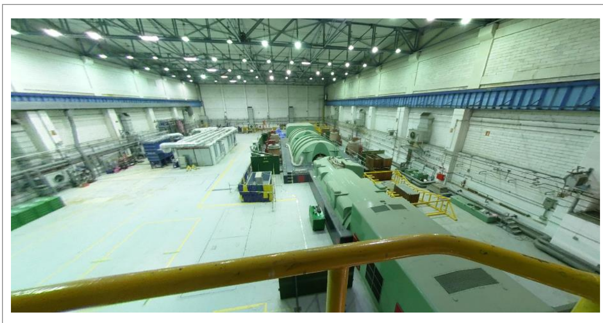
Figura 7: Situación actual de la Planta de Operación del Edificio de Turbina.
