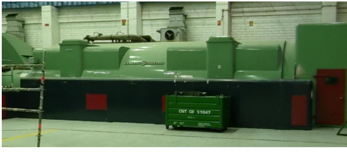
Figura 13: Faldón estátor (verde oscuro)
