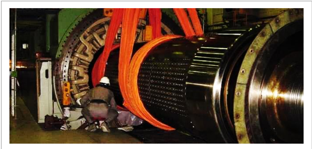
Figura 10: Rotor durante el proceso de extracción (2)
