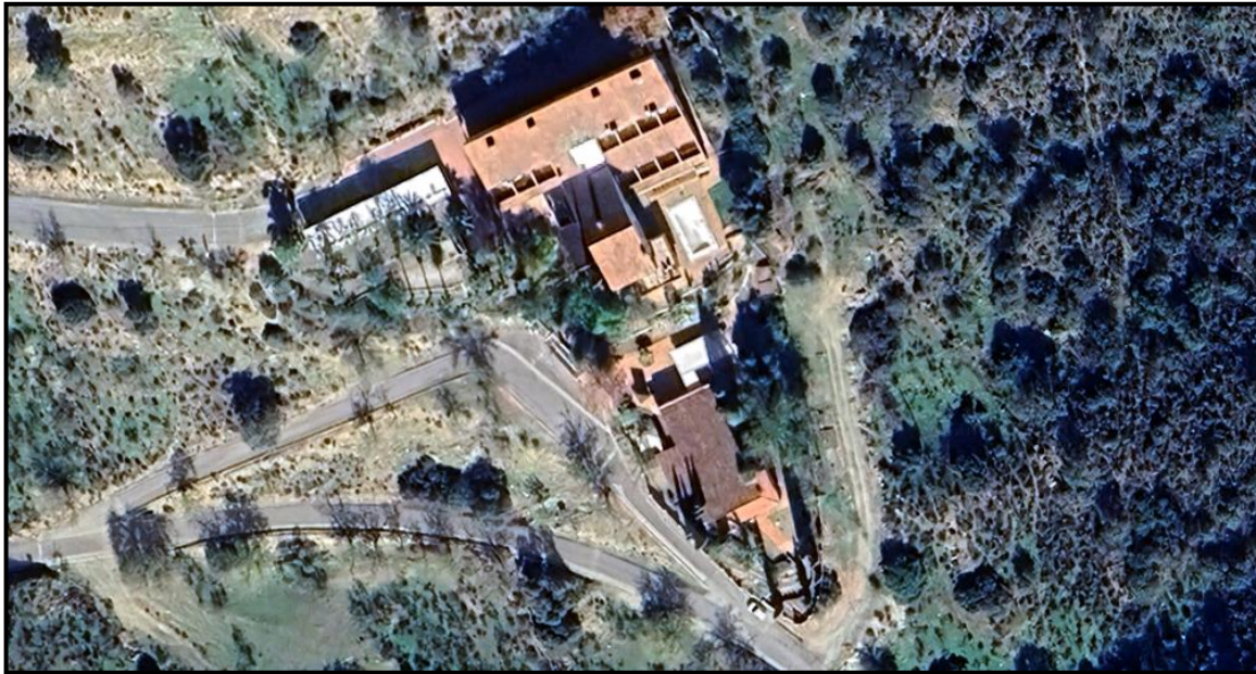
Ilustración 2: Vista aérea de Residencia.
