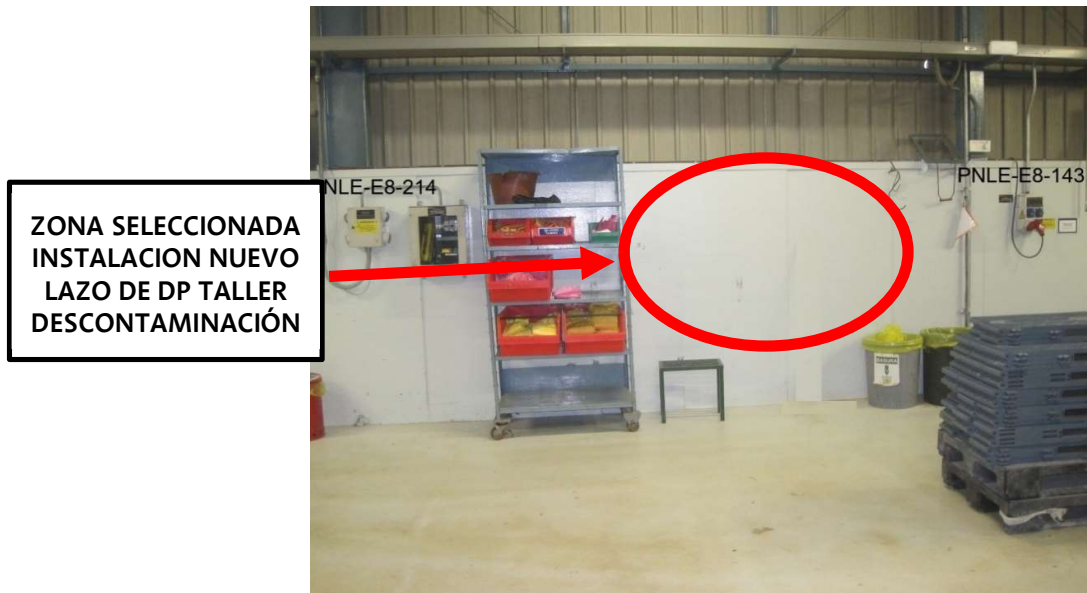
Figura 4.2-2: Pared norte taller de descontaminación (zona E2.06.00, elevación 518,00)
