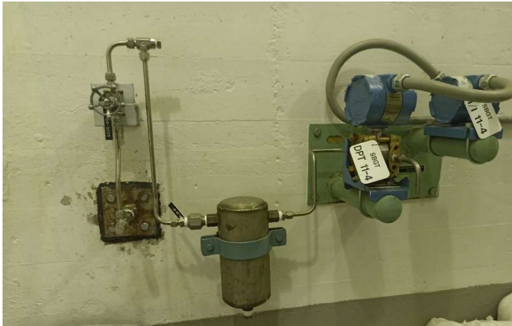
Figura 3.1: Fotografía actual lazo sistema de medida de DP del edificio del reactor (lazo principal) (DPT-11-4)
