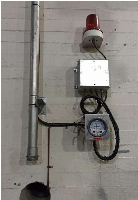
Figura 3.4: Fotografía y esquema eléctrico actual lazo sistema de medida de DP del edificio auxiliar de procesado (EAP) (DPIS-28-59)
