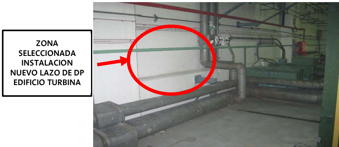
Figura 4.5-2: Edificio turbina. Planta operación turbina. Pared sur, ejes 8 y 9 (zona T3.01.00, elevación 524,40).
