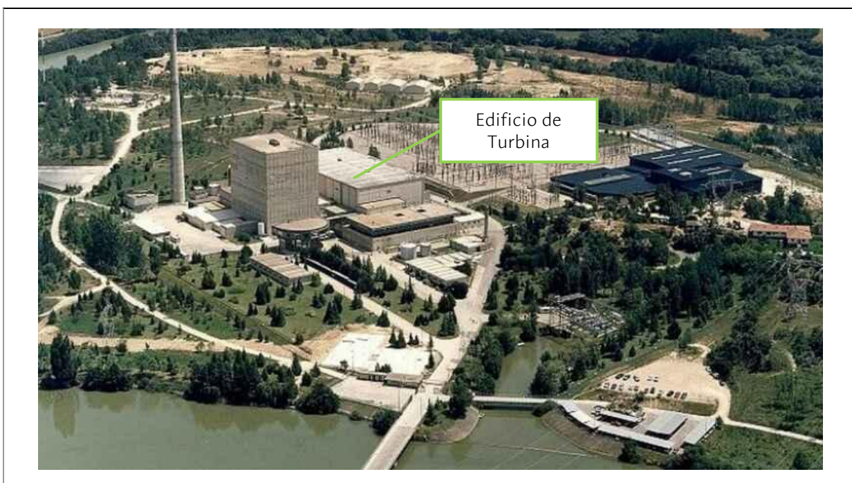
Figura 1: Vista aérea de CNSMG.
