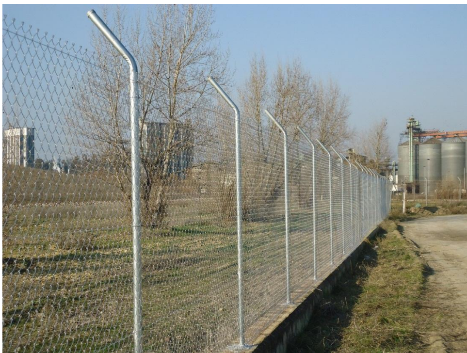
Fotografía 1: Detalle del vallado perimetral.
