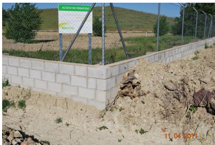
Fotografía 3: Cartelería de aviso.
