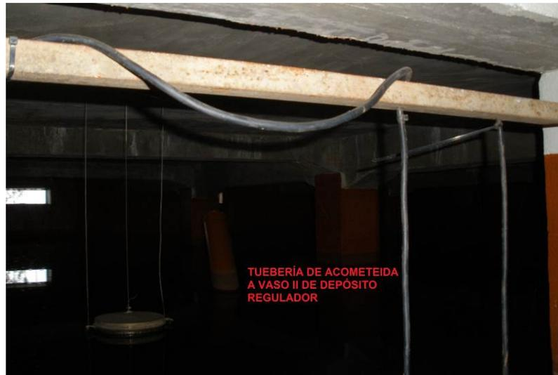
Figura 3. Tubería de entrada a Vaso II de depósito regulador K-AF-TQ01
